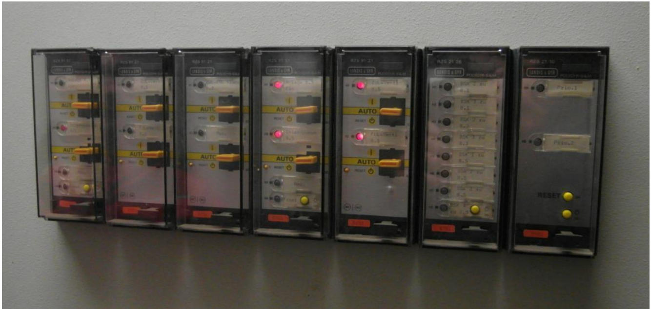
Steuerung der Lüftung Garderobe; Geb. 17a
