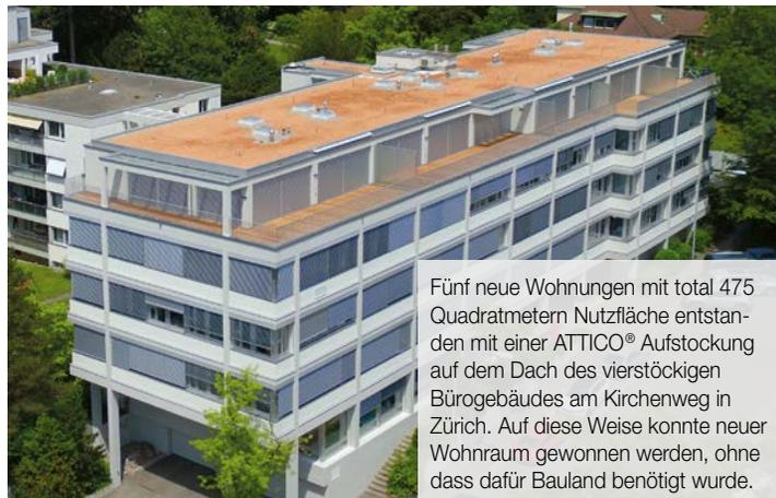
Fünf neue Wohnungen mit total 475 Quadratmetern Nutzfläche entstanden mit einer ATTICO® Aufstockung auf dem Dach des vierstöckigen Bürogebäudes am Kirchenweg in Zürich. Auf diese Weise konnte neuer Wohnraum gewonnen werden, ohne dass dafür Bauland benötigt wurde.
