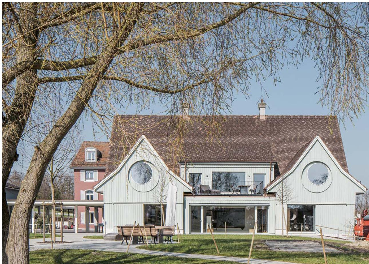
Die beiden alten angebauten Scheunen auf der Rückseite des Schulhauses wurden im selben Volumen durch zwei neue Holzrahmenbauten ersetzt. Zwischen ihnen liegt der Gruppenraum, hinter dem die Treppenhalle die Schulräume miteinander verbindet.
