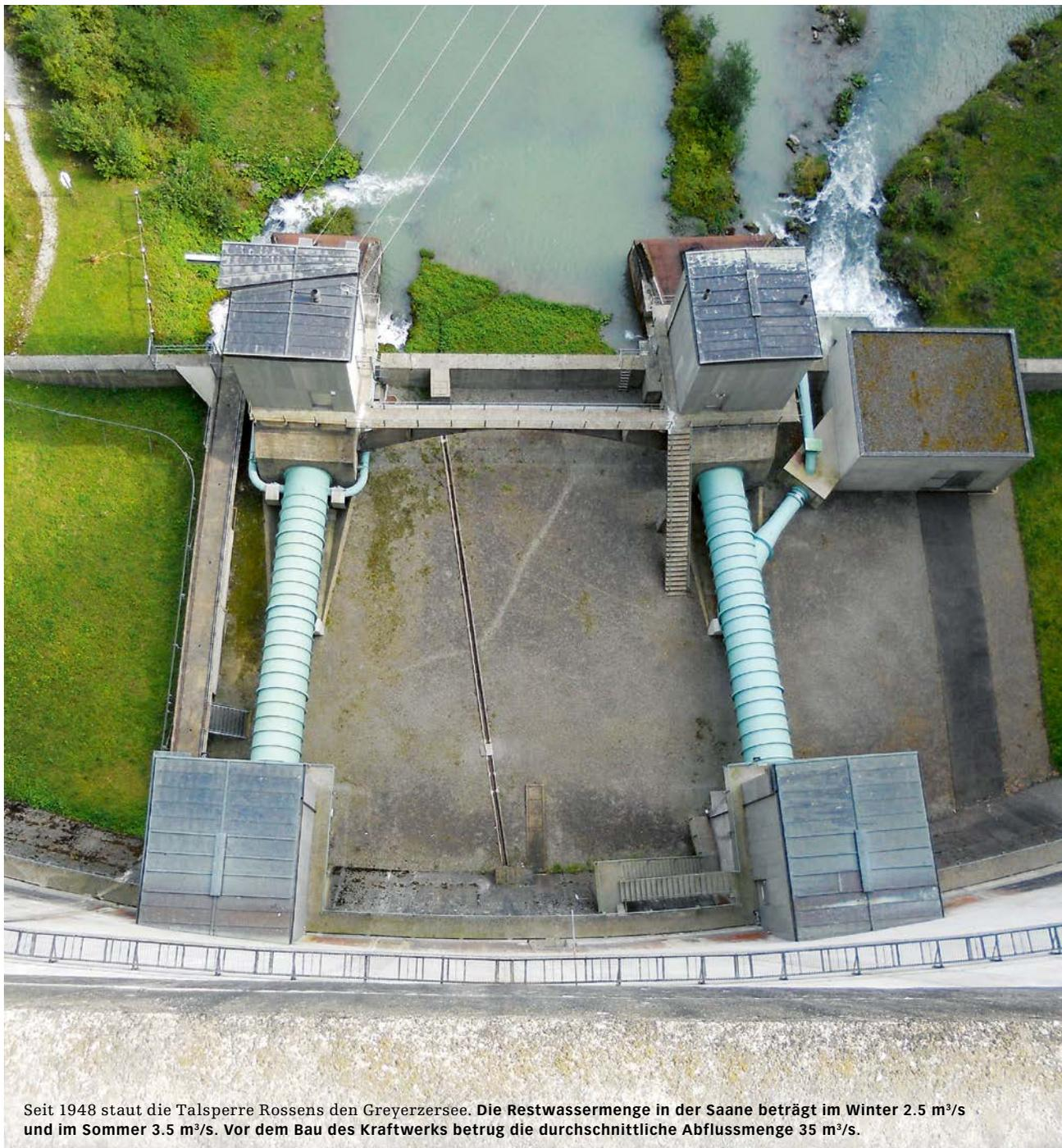
Seit 1948 staut die Talsperre Rossens den Greizersee. Die Restwassermenge in der Saane beträgt im Winter  $2.5 \text{ m}^3/\text{s}$  und im Sommer  $3.5 \text{ m}^3/\text{s}$ . Vor dem Bau des Kraftwerks betrug die durchschnittliche Abflussmenge  $35 \text{ m}^3/\text{s}$ .
