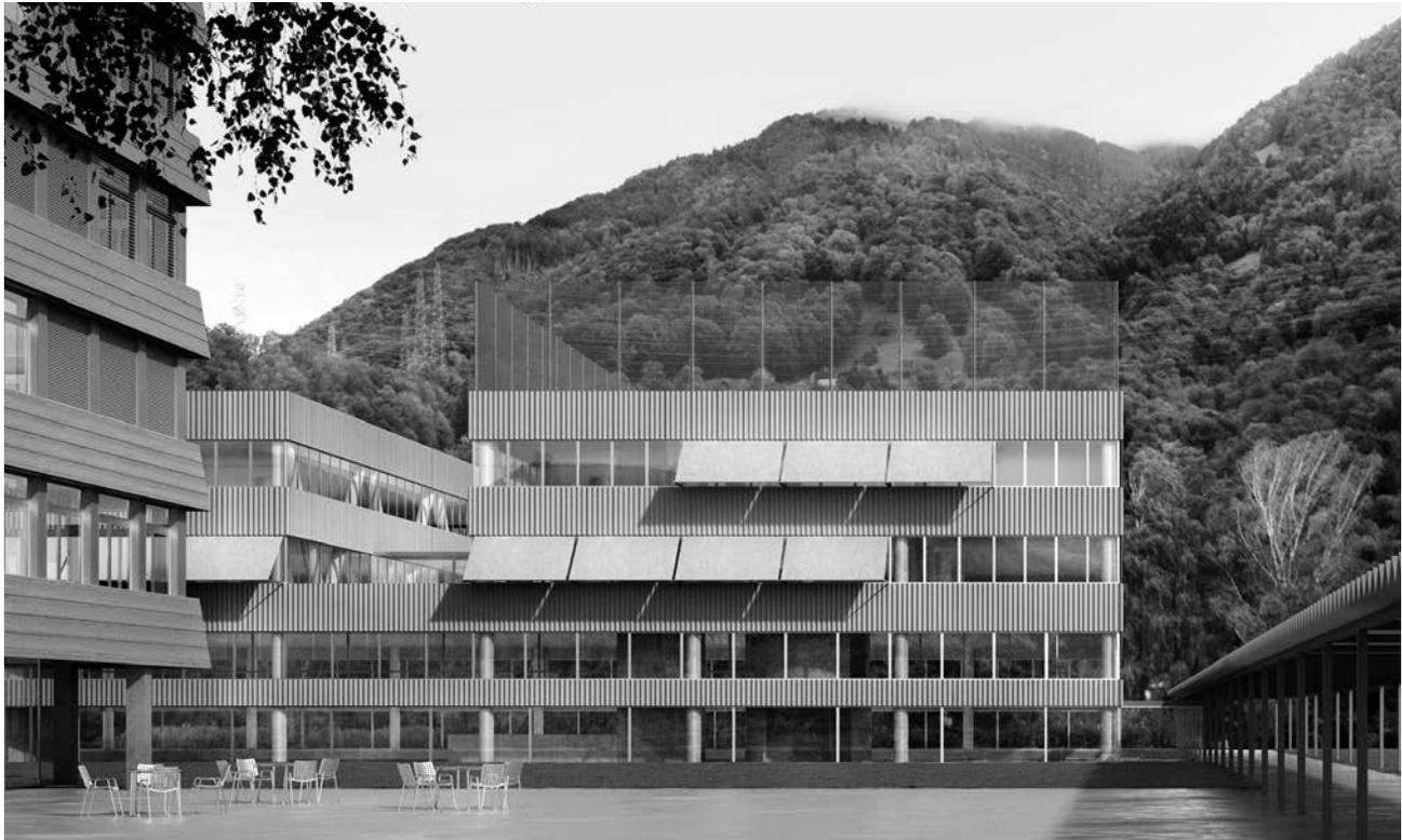
Der erste Preis, «Brückenbauer» von Thomas Fischer Architekt mit Dr. Deuring + Oehninger, nimmt mit den durchlaufenden Fassadenbändern und den Brüstungen aus gewellten Zementplatten Bezug zum Altbau.
