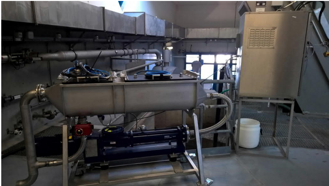
Abbildung 63: Bestehender Probenehmer Zulauf ARA (nach Rechen)
