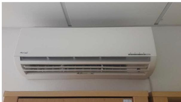
Abbildung 88: Inneneinheit vom Splitgerät
