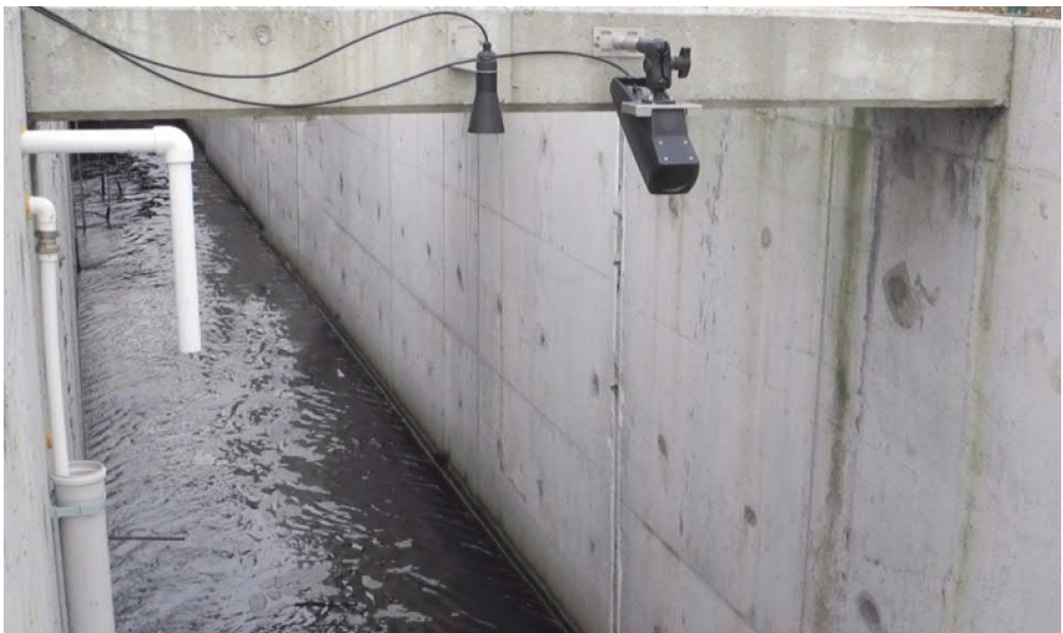
Abbildung 26: Beispiel eines Radar-Durchflusssystemes
