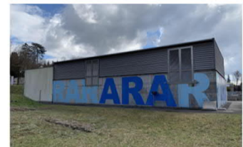
Best. Filtrationsgebäude Sockel Sichtbeton mit Schriftzug Aufbau Sinusblech liegend, Türen RAL 9007 Graualuminium Anbau Verputzt weiss
