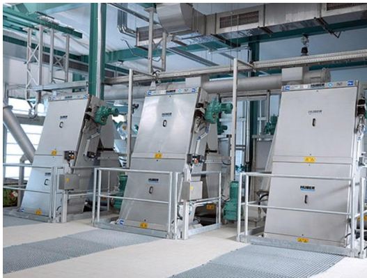
Abbildung 27: Beispiel eines 3-strassigen Feinrechens
