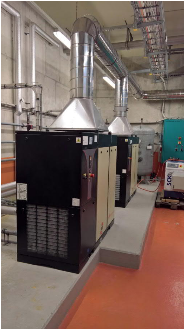
Abbildung 62: Bestehende Druckluftanlage
