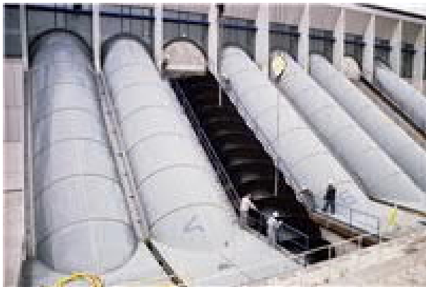
Abbildung 24: Beispiel von gedeckten Schneckenhebewerken
