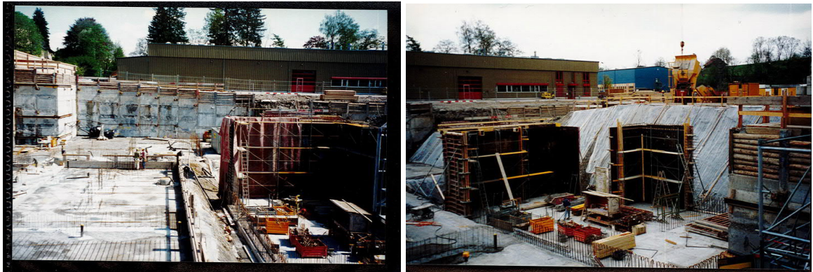
Abbildung 70: Fotos; Baugrubensicherung gegen den Werkhof
