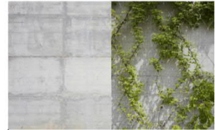
Sichtbetonscheibe Schalungstyp 2
