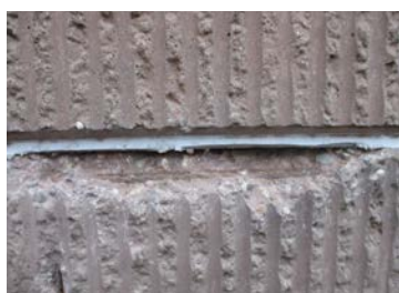
Abplatzungen am profilierten Element
