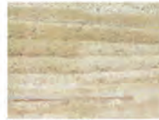
Mur en argile pisé
