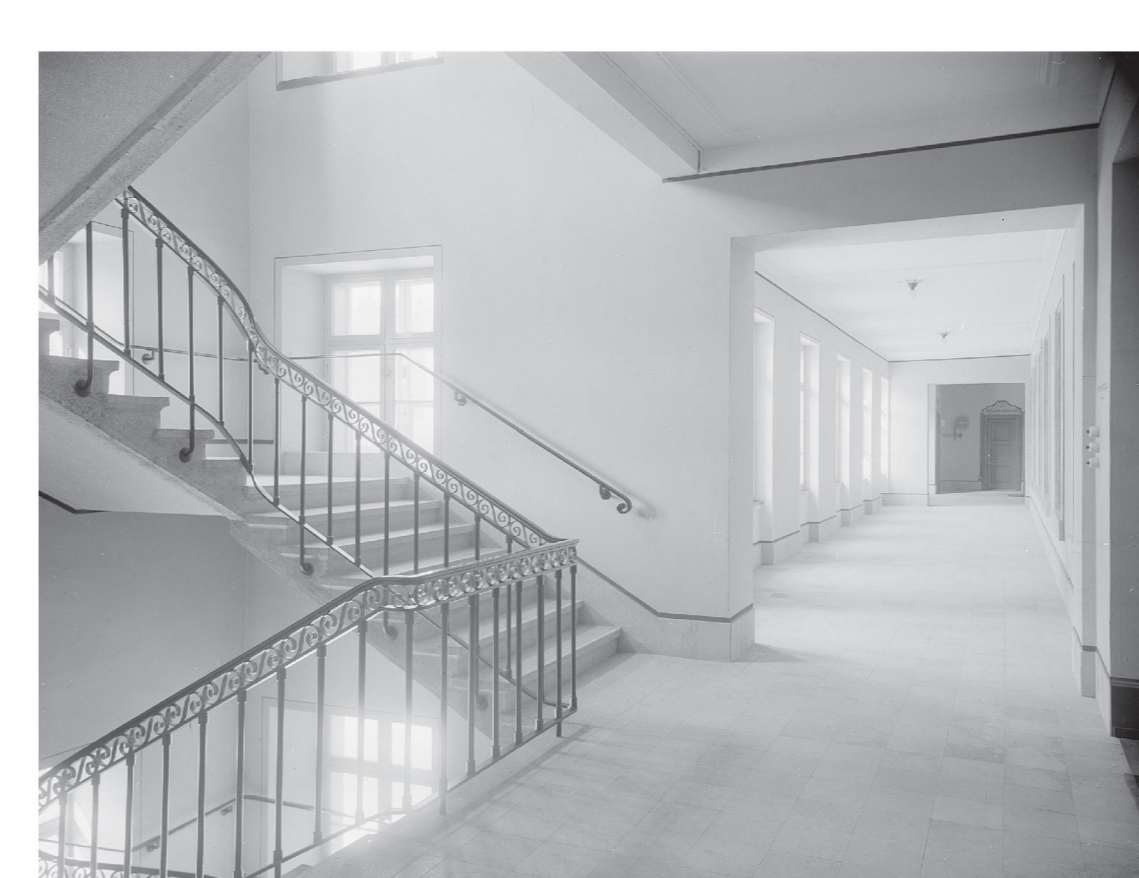
Treppenhaus im Bestandsbau, um 1929. So war es, so soll es wieder sein: die grosszügig und natürlich beleuchteten Treppenhäuser in den Seitenrisaliten des Bestandsbaus sollen sich durch die Verlegung der Liftbahnen wieder in ihrer ursprünglichen Räumlichkeit präsentieren.
