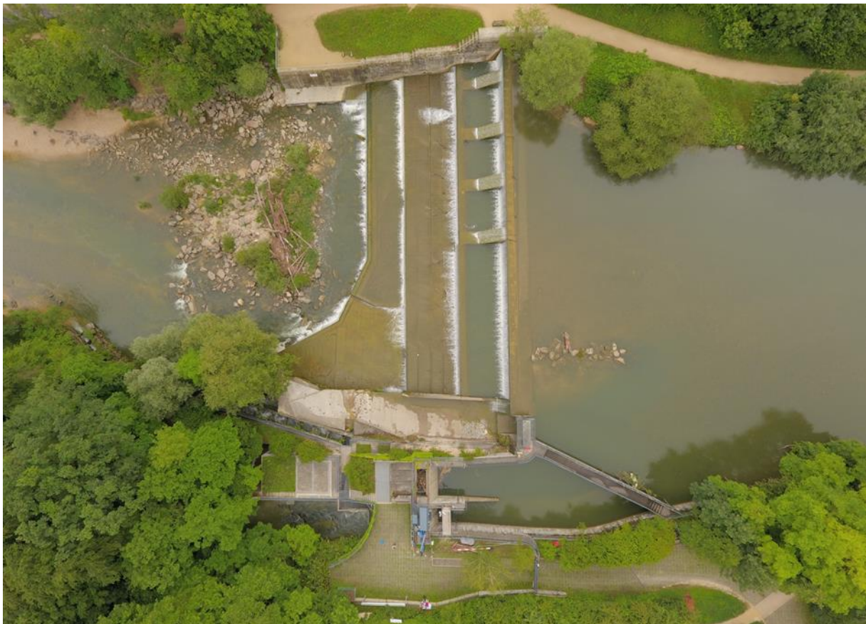
Abbildung 26: Luftbild des Kraftwerks Neuwelt mit Ableitung in den St. Alban Teich. Der Fischpass befindet sich am linken Ufer. Foto vom 7.6.2018.
