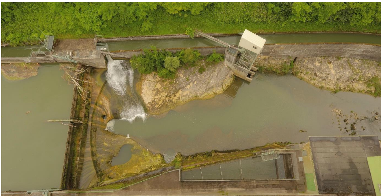
Abbildung 21: Luftbild des Ausleitungswehres mit Fischlift am KW Büttenen. Foto vom 7.6.2018.
