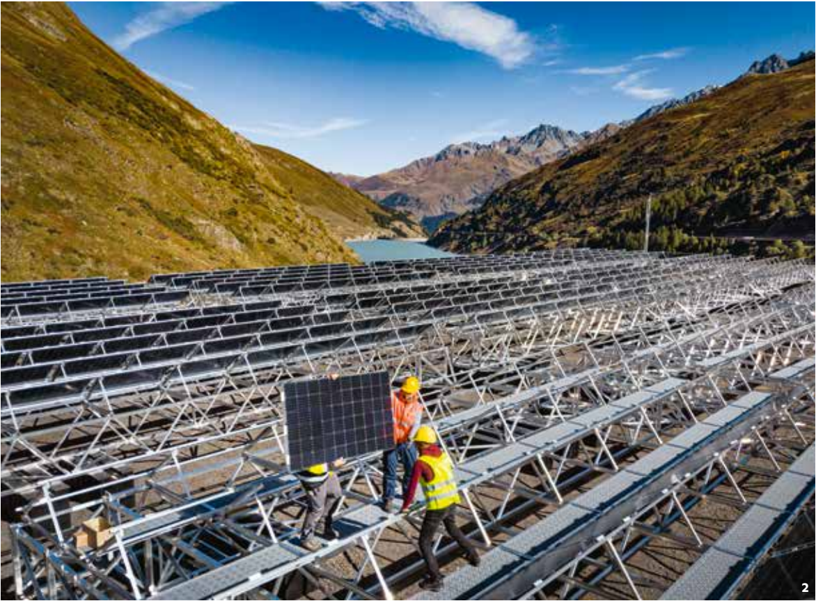
1,4,5 Parc solaire flottant du lac des Toules (VS): les 2240 m 2 de panneaux photovoltaïques bifaciaux, installés sur 36 flotteurs, produiront 0,8 GWh/an. 2 Installation des modules photovoltaïques à proximité du lac des Toules
