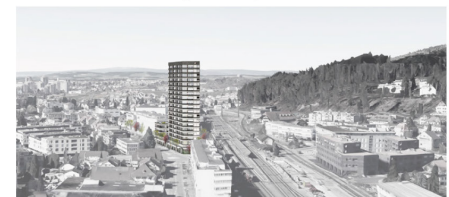
Der Verlauf in den Natursteinfassaden korrespondiert mit dem dichten, dunklen Wäldchen auf dem nahe gelegenen Hornbühl.
