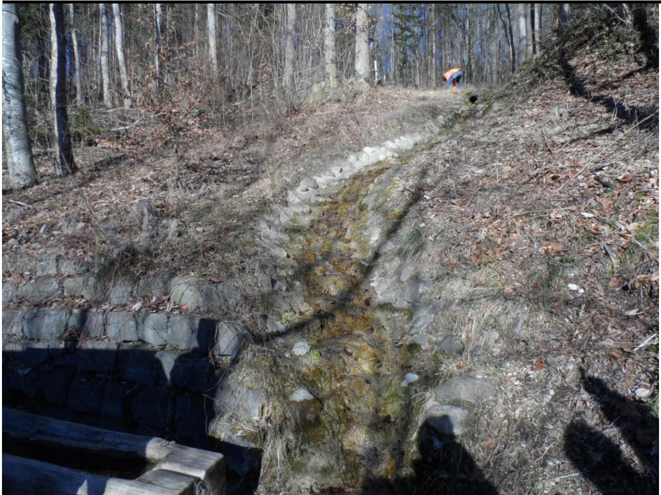
Abbildung 132 Foto bestehende Hangentwässerung
