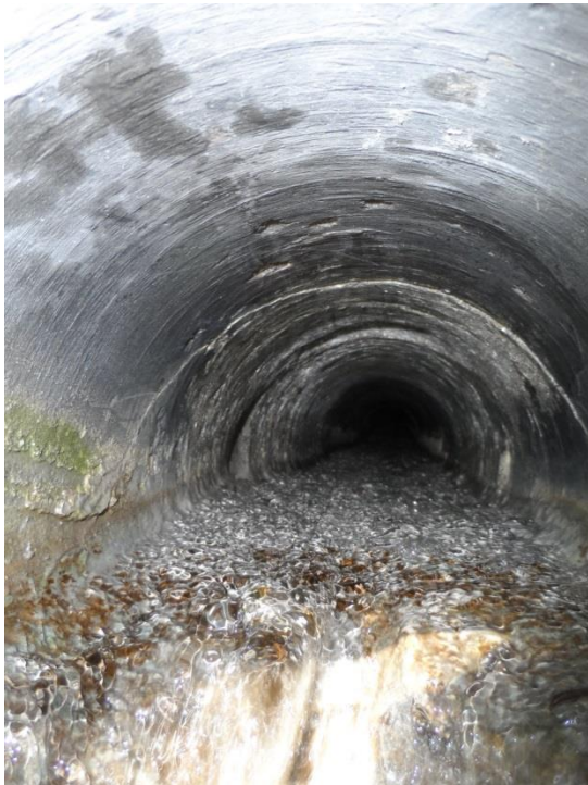
Abbildung 23 Fotos verkalkte Entwässerungsröhre
