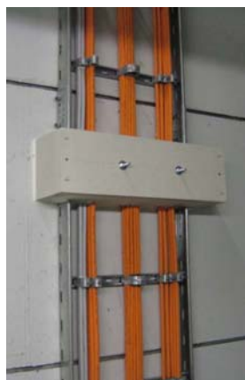
Abbildung 1, Zugentlastung mit Brandschott + Kabelschellen
