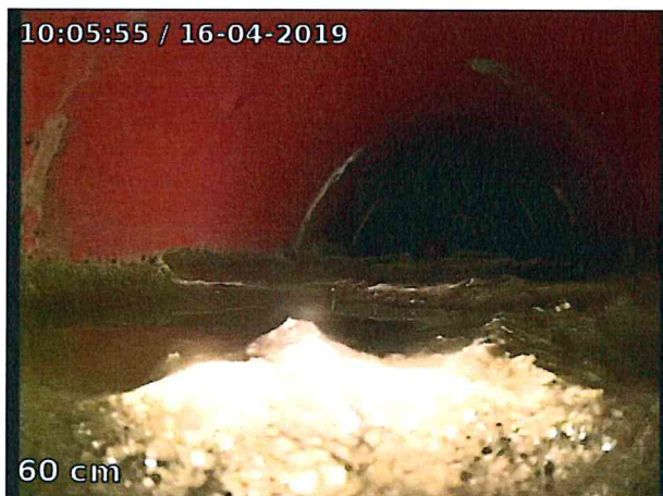
Photo: 10_2A, 00:00:43 0.6m, Dépôts durs, important de 02 à 10 h., Début du dommage
