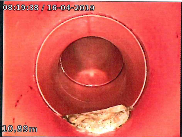
Photo: 2_11A, 00:01:47 11m, Dépôts durs, léger de 05 à 07 h.
