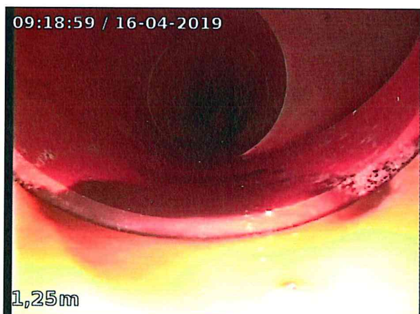
Photo: 5_4A, 00:00:29 1.25m, Embranchement à 03 h., en bon état
