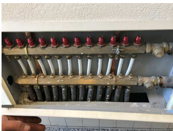
Figure 7 : Coffret alimentation radiateurs
