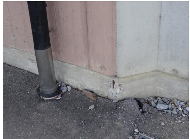
Fissure et éclat rendant l'armature visible
