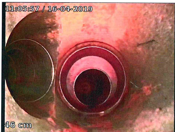
Photo: 13_2A, 00:00:31 0.45m, Embranchement à 09 h., en bon état
