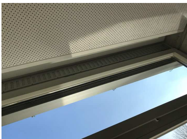
Figure 13 : Amenée d'air frais
