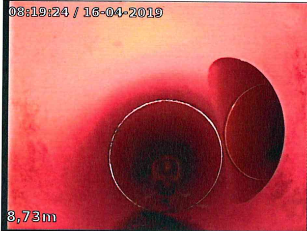
Photo: 2_9A, 00:01:33 8.73m, Embranchement à 03 h., en bon état
