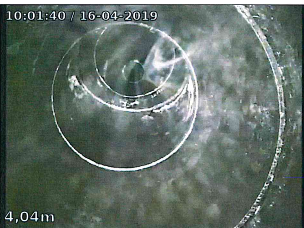
Photo: 8_6A, 00:00:52 4.05m, Interruption de l'inspection / La caméra ne remonte pas la colonne de chute
