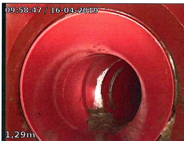
Photo: 7_2A, 00:00:34 1.29m, Coude à droite / avec léger dépôts durs au radier
