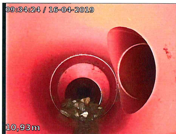
Photo: 6_9A, 00:01:28 10.9m, Embranchement à 03 h., en bon état
