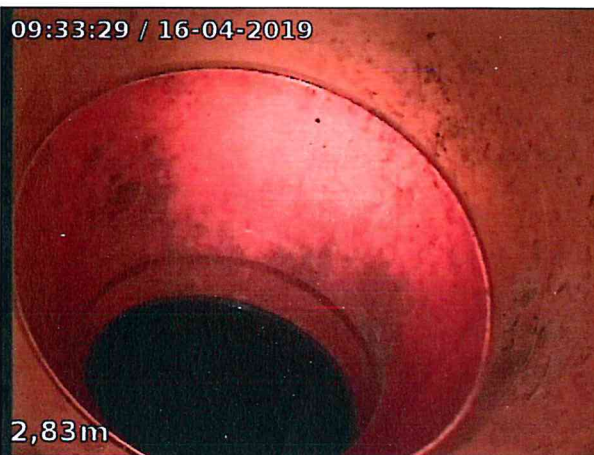
Photo: 6_3A, 00:00:33 2.9m, Coude à l'horizontale
