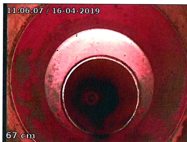
Photo: 13_3A, 00:00:37 0.65m, Diminution du diamètre
