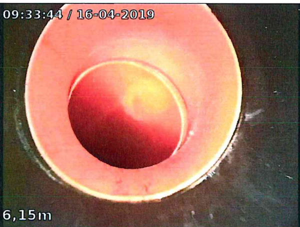
Photo: 6_6A, 00:00:48 6.3m, Coude à l'horizontale
