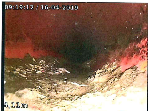
Photo: 5_6A, 00:00:42 4m, Dépôts durs, léger de 05 à 07 h., Début du dommage
