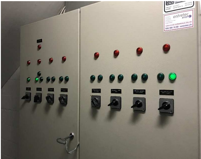
Figure 23 : Tableau de régulation ventilation
