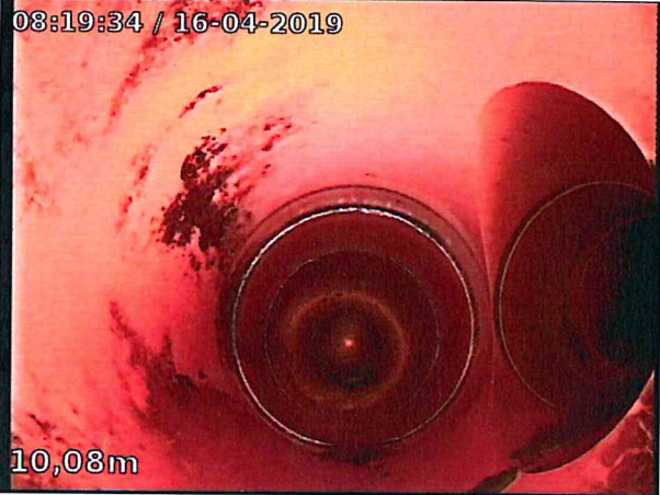
Photo: 2_10A, 00:01:43 10.08m, Embranchement à 03 h., en bon état
