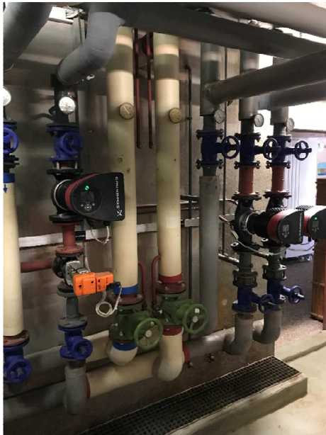
Figure 3 : 1 er collecteur chauffage
