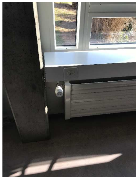
Figure 7 : Radiateur salle de classe
