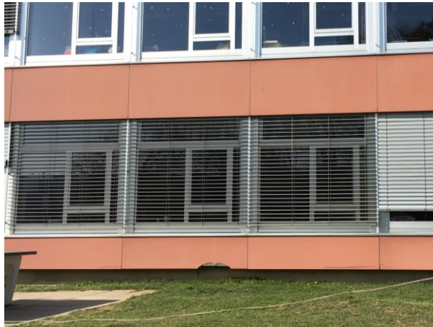
Plaque inférieure endommagée
