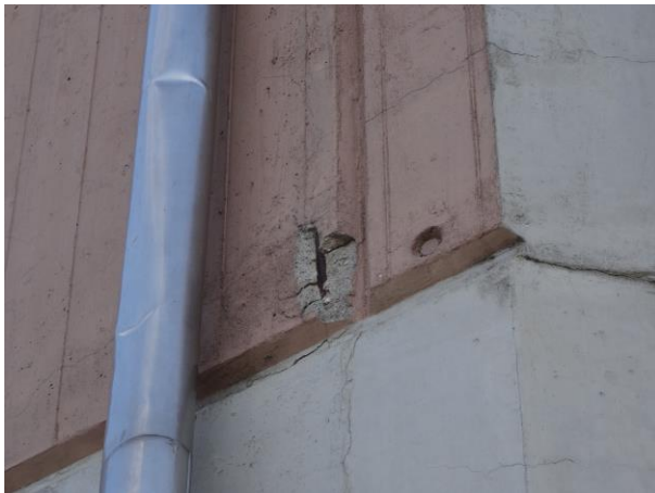
Fissure et éclat rendant l'armature visible
