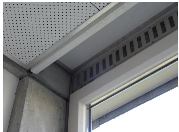
Grille de ventilation sur la partie supérieure
