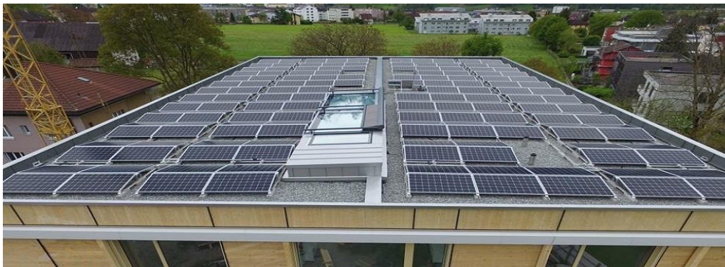
PV-Anlage mit Ost-/Westausrichtung
