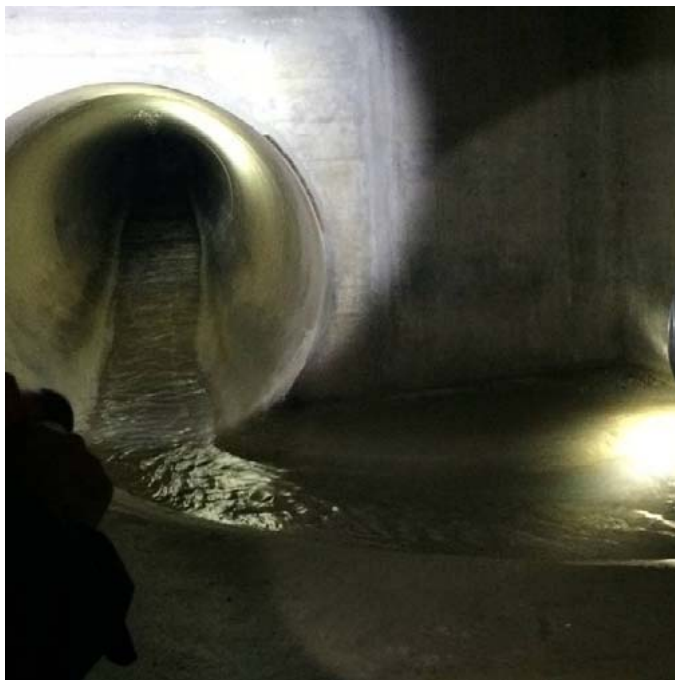
Vue sur la chambre avec la conduite de sortie de l'ouvrage. A droite les eaux venant du limiteur de débit. Les eaux de vidange ou de trop-plein du bassin de rétention rejoignent la conduite de sortie également dans cette chambre.
