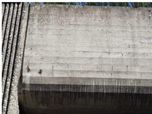
Bac à fleurs en façade : éclatement béton, armatures apparentes
