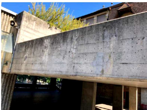
Fissures et anciennes réparations
