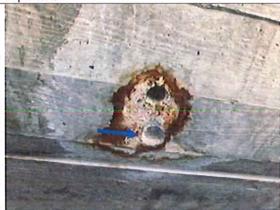
Aspect d'une infiltration située au droit d'un écoulement d'un bac à fleurs (CI1)
