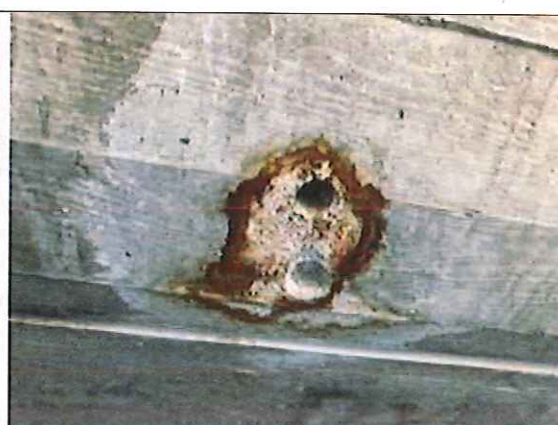
Aspect rapproché du prélèvement de béton Cl1 au droit d'une tache pour détermination de la teneur en chlorure dans le béton (sur les 2 premiers centimètres)
