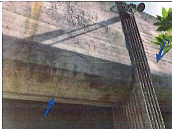
Eclats de béton et éclats en formation visibles en sous-face de bacs à fleurs côté avenue de la Praille, au niveau de la partie basse
