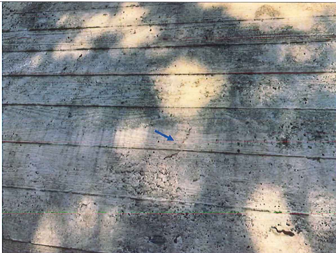
Aspect d'un éclat de béton en formation au droit d'un acier vertical
