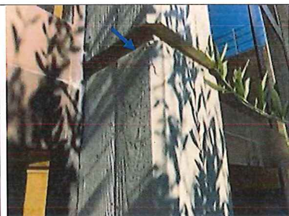
Eclat de béton en formation sur un angle
