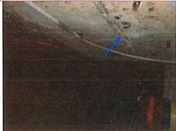
Prélèvement du CI 4 en intrados de dalle du bassin tampon, sur zone non dégradée
