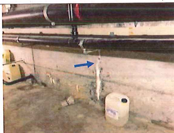
Prélèvement du CI 3 au droit d'une coulure avec résurgence de chaux carbonatée sur mur périphérique du bassin de la piscine
