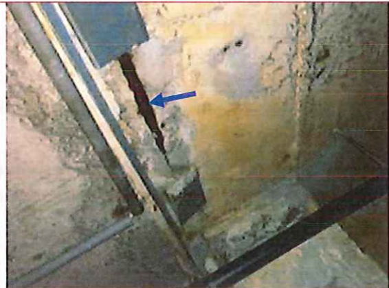
Entrée bassin tampon : aspect d'une armature mise à nu fortement oxydée avec perte de section importante
