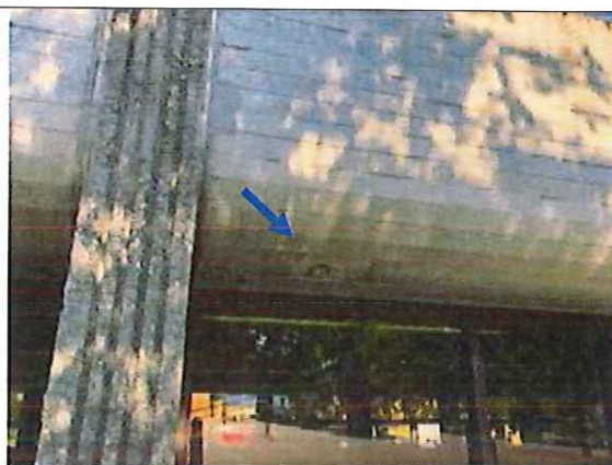
Aspect d'une pipette d'évacuation d'eau présentant une tache marron en surface de béton
