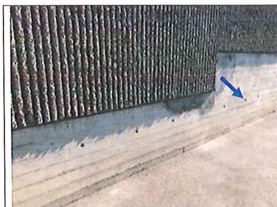
Aspect d'une partie du mur en béton brut et implantation du sondage S10 Notons que des réparations ont déjà été réalisées
