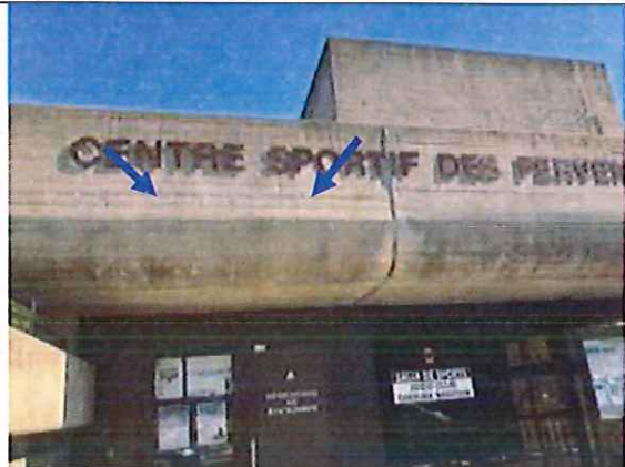
Anciennes réparations visibles sur des aciers verticaux
