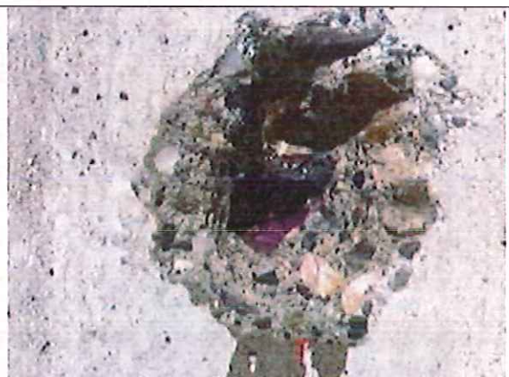
Aspect rapproché du sondage S8 étrier, \varnothing 8 mm type Caron enrobage 21 mm, légèrement oxydé Front de carbonatation du béton : 27 à 29 mm Enrobage étriers voisins (mm) : 21 – 21 – 20 – 19 – 20 ( aucune dégradation visible )- 11 – 13 – 13 – 10 – 11 – 9 – 10 ( éclats de béton en formation au droit d'aciers oxydés)
