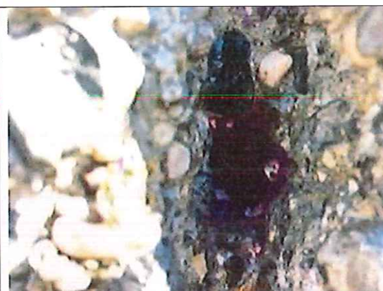
Aspect rapproché sur sondage S9 Front de carbonatation du béton : 2 à 4 mm Enrobage moyen des aciers (mm) : \geq 23 mm
