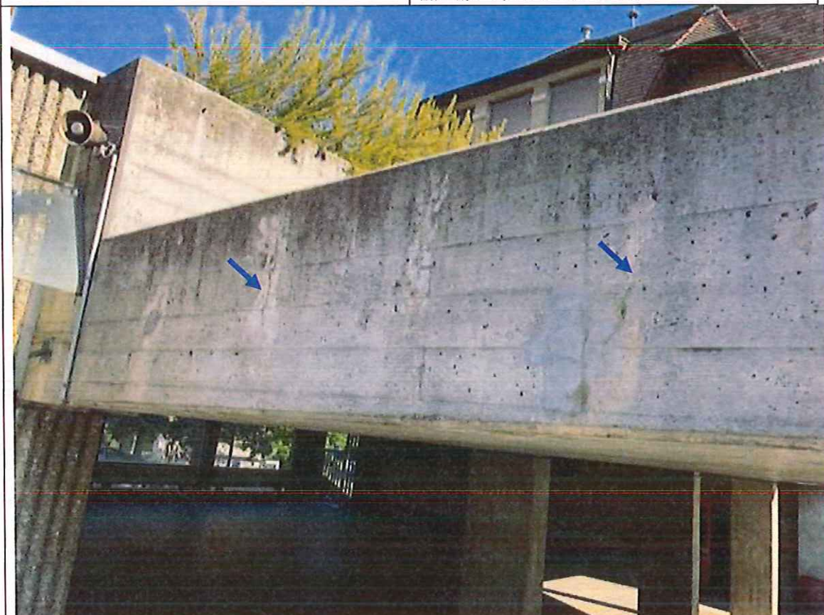
Nombreuses fissures verticales sur aciers notamment sur d'anciennes réparations
