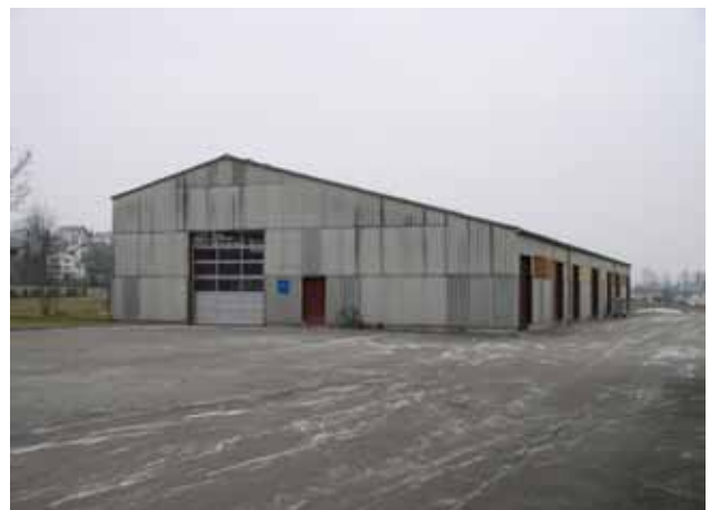
1 Mit Wellplatten aus Faserzement verkleidete Industriehalle
