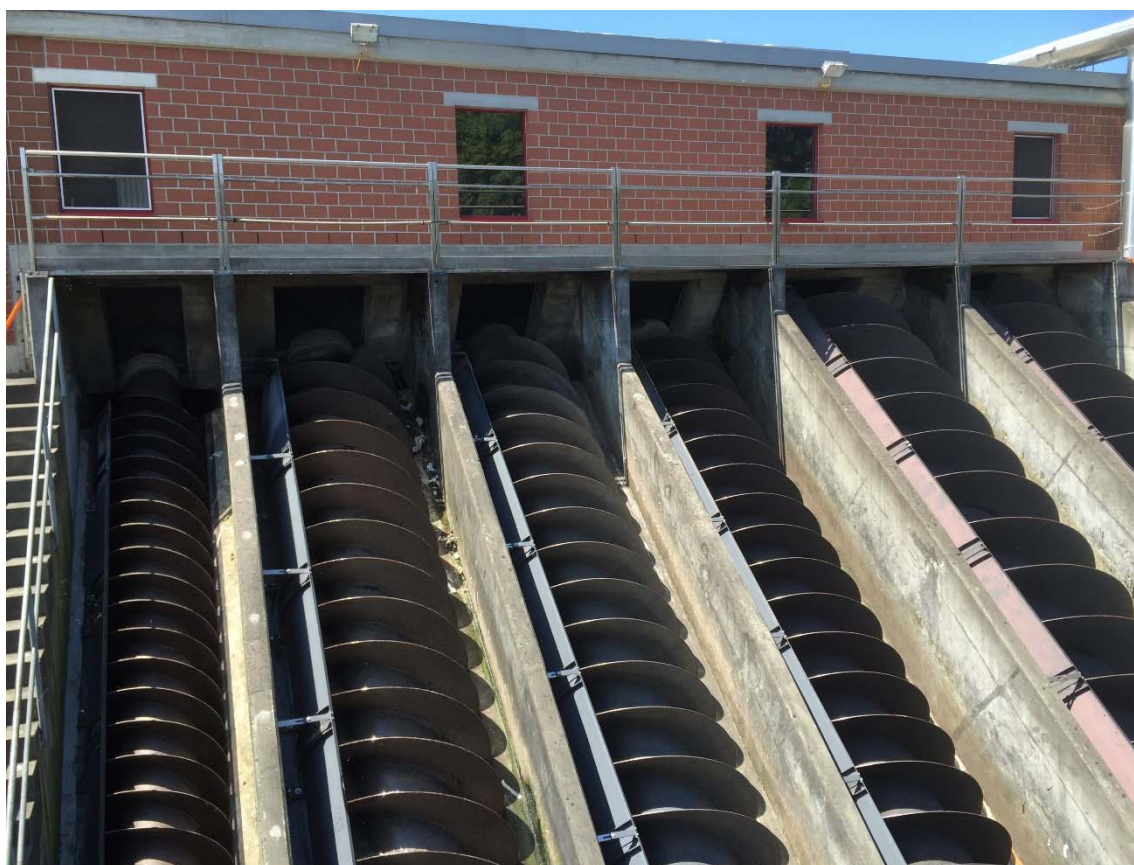
Abb. ARA-Einlaufhebewerk
