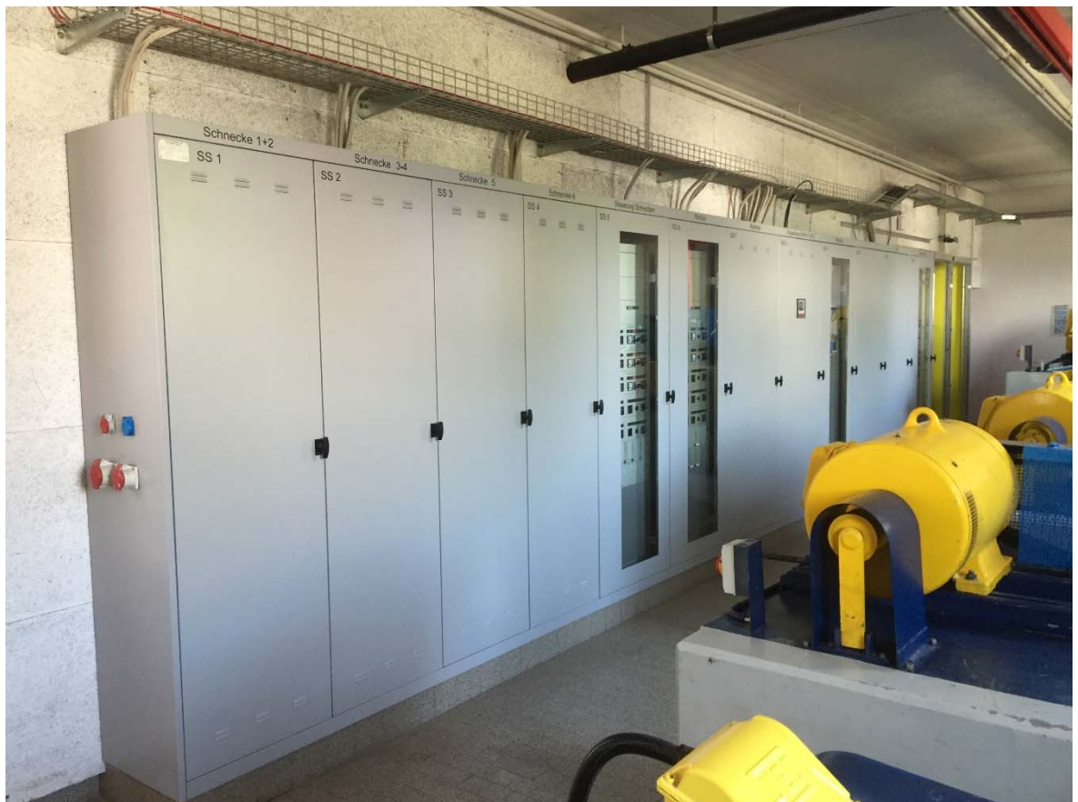
Abb. 2.6-1 Schalt- und Steuerschrank SW16
