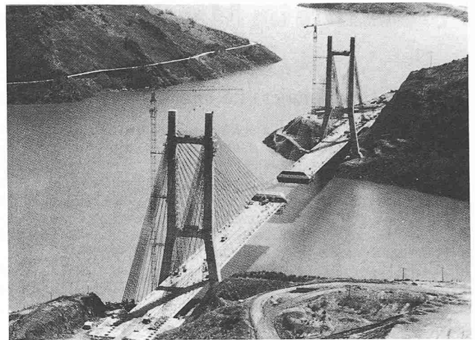
Bild 10. Schrägseilbrücke als Vielseilsystem
