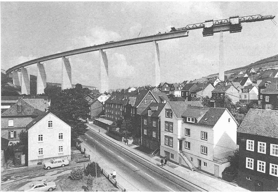
Bild 3. Kombination von Vorschubgerüst und Freivorbau
