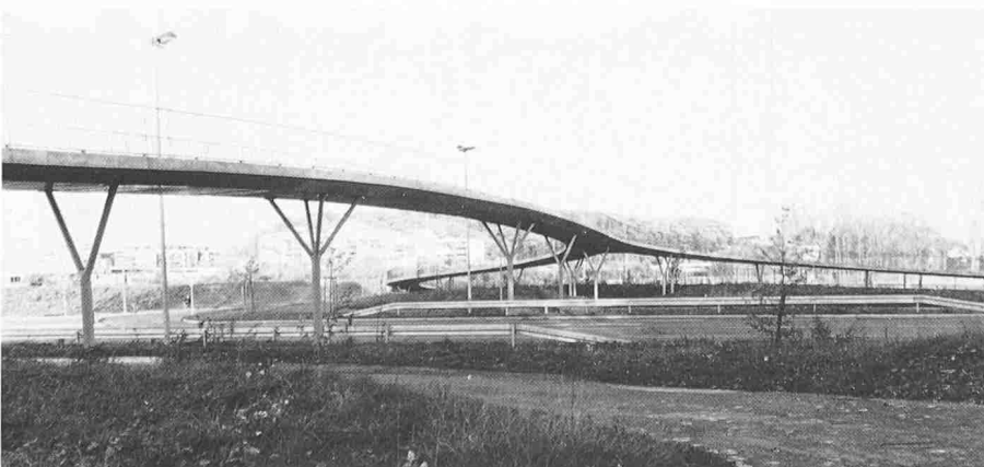
Bild 9. Fussgängerbrücke in Sindelfingen (gebaut 1986)
