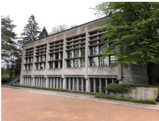
Foto 3 / «Neue Turnhalle», inventarisiert
