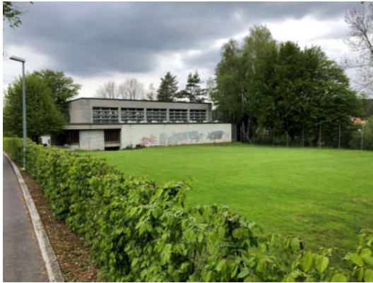
Foto 1 / «Neue Turnhalle», inventarisiert
