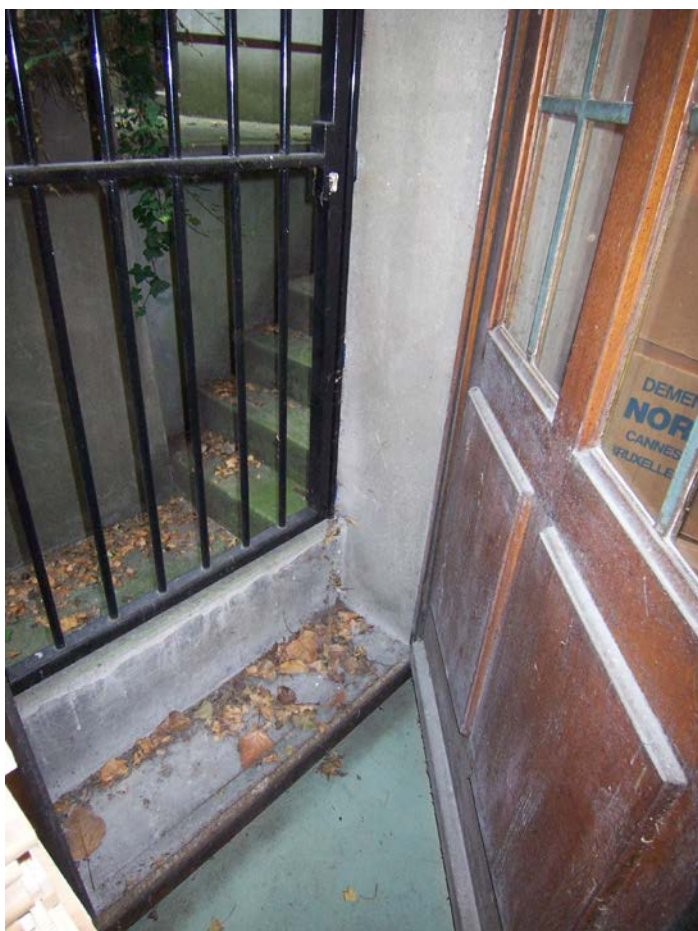
Porte vers le fossé N : les restes végétaux devraient être nettoyés régulièrement. La porte devrait être plus étanche (climat + insectes).
