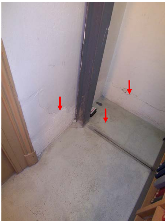
Fissures dans le sol et dans le mur, passage de fourmis.
