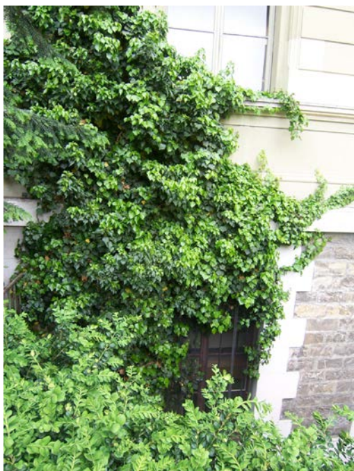
Fossé Eynard, côté E : végétation envahissante, accumulation de feuilles qui rendent difficile l'écoulement des eaux de pluie et tendent à maintenir humide le bâtiment.
