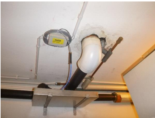
50 – Passages de gaines techniques sans obturation résistante au feu
