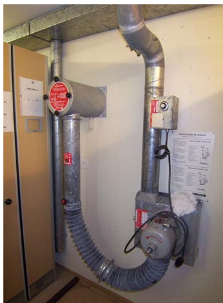
La ventilation de secours n'est pas étanche ; elle amène dans le dépôt de l'air extérieur et l'odeur de fumée des cigarettes fumées devant l'entrée de service.
