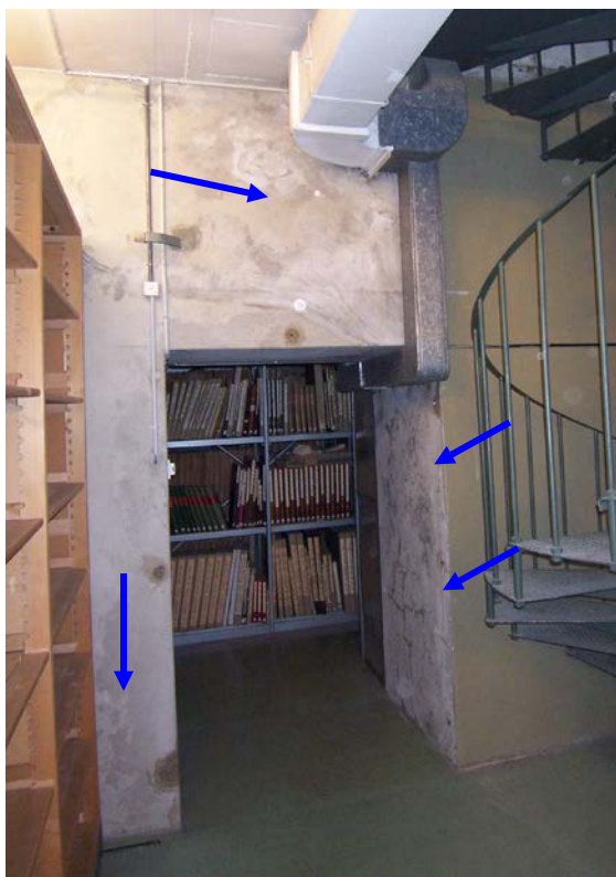
← Mur avec fortes infiltrations par capillarité.
