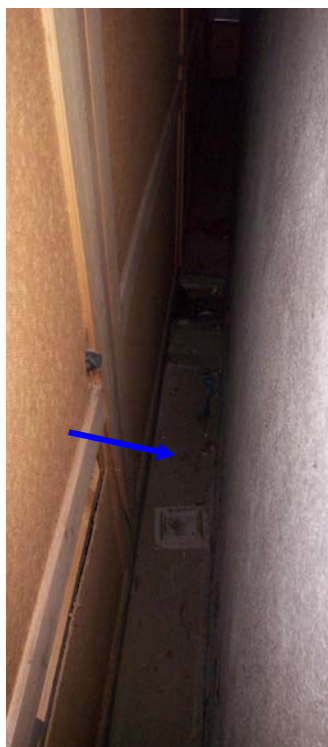
← Mur avec fortes infiltrations par capillarité.
