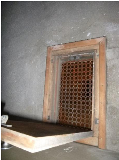
54 – Ouverture non compartimentée avec la cage d'escalier principale
