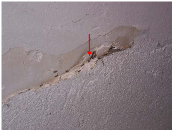
Fissures dans le sol et dans le mur, passage de fourmis.
