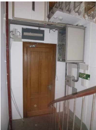
15 – Gaines techniques non compartimentées dans la voie d'évacuation verticale
