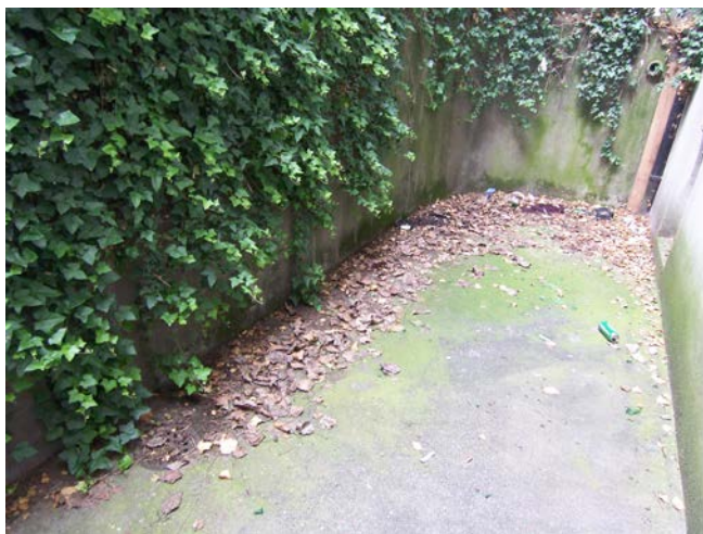
Fossé Eynard, côté E : végétation envahissante, accumulation de feuilles qui rendent difficile l'écoulement des eaux de pluie et tendent à maintenir humide le bâtiment.
