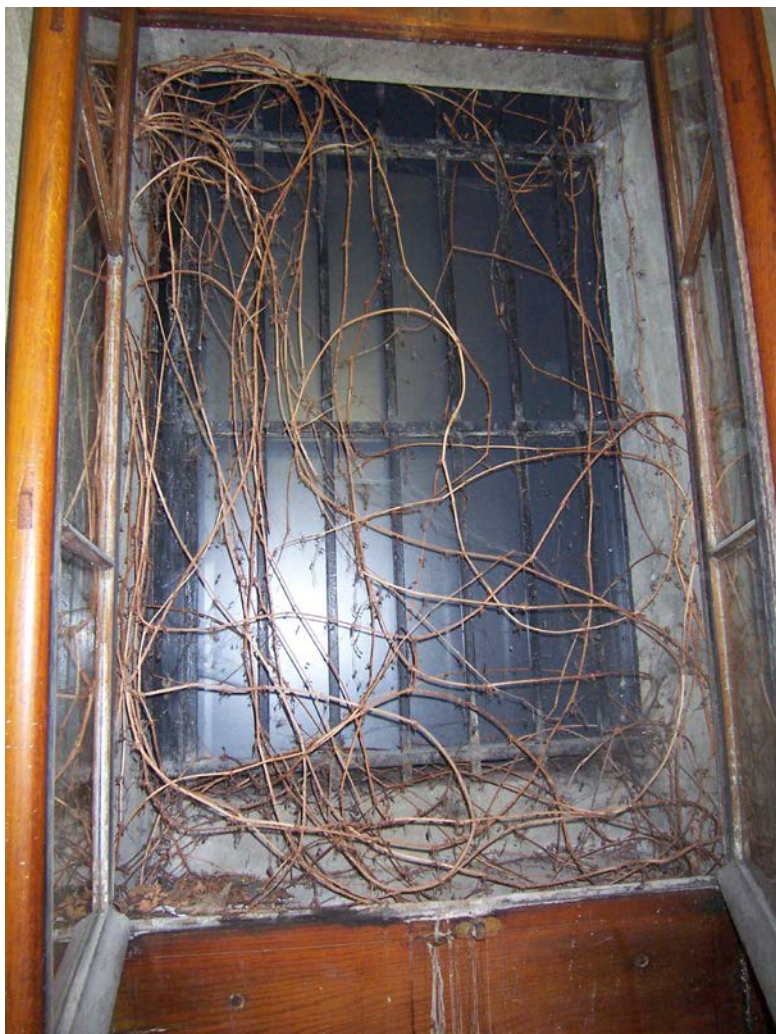
Fenêtre côté S, fermée à l'extérieur par une plaque métallique. Végétation séchée et signes d'anciens écoulements d'eau ponctuels. Les restes végétaux devraient être éliminés pour éviter de créer un biotope tout près des magasins.
