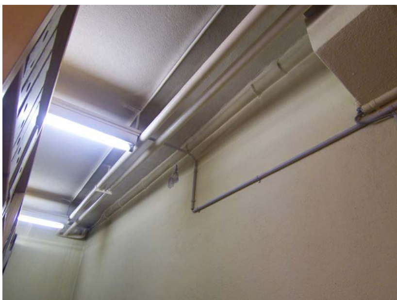
Tuyaux d'alimentation des radiateurs du Niveau 2 ; ancienne conduite partiellement intégrée dans le mur.
