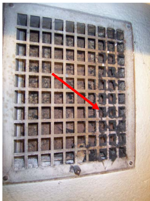
Grille de ventilation en communication directe avec l'extérieur.
