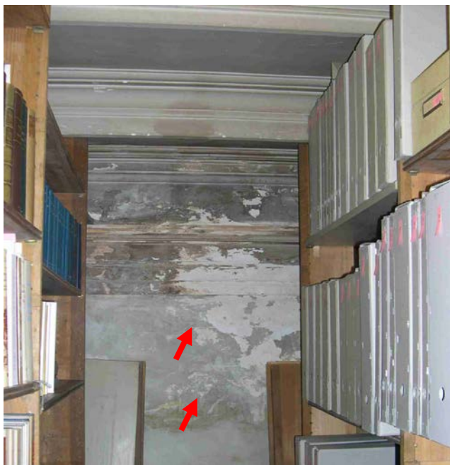
Taches d'anciennes infiltrations d'eau dans le mur, crépi en mauvais état.
