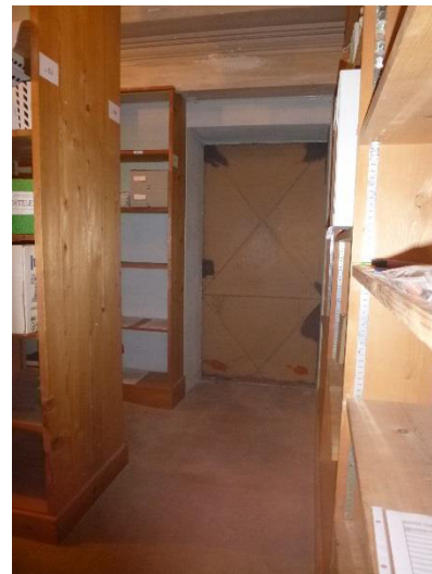
16 – Paroi servant compartiment coupe-feu, issue de secours non signalée
