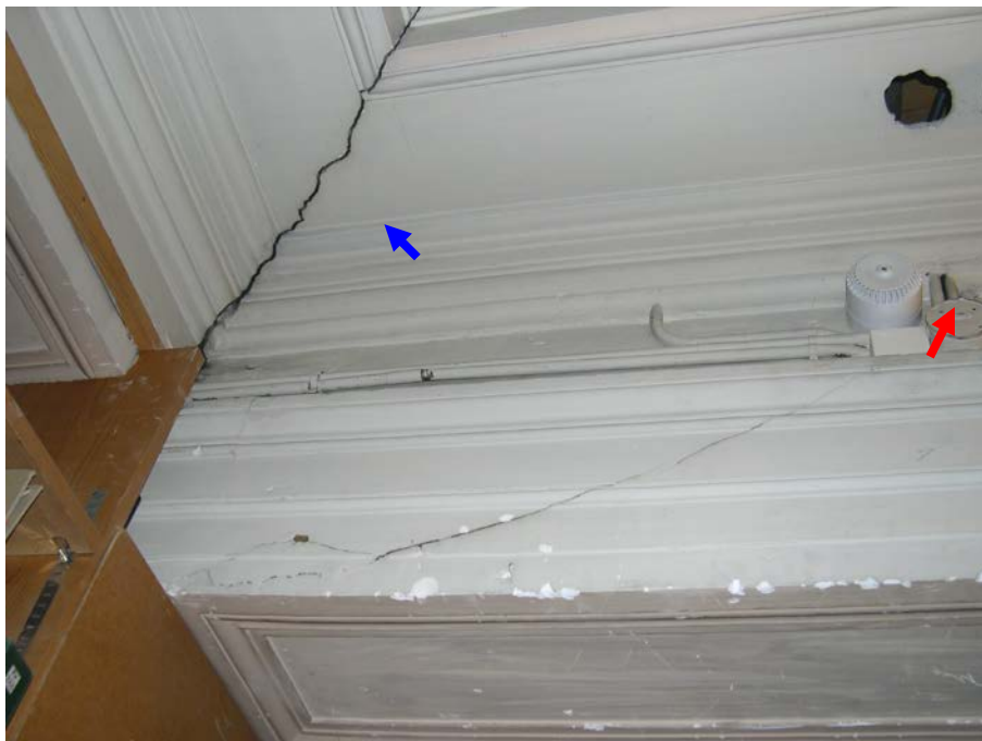
Importantes fissures, installations électriques de diverses époques.
