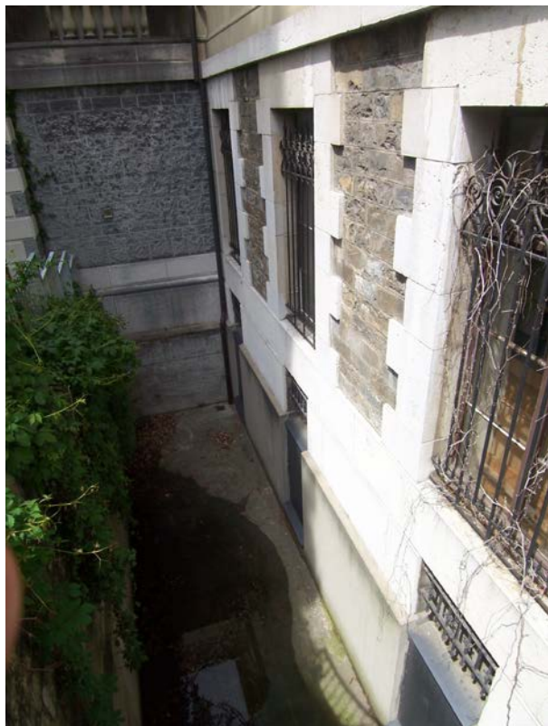
Fossé Candolle, côté S : ce fossé est inaccessible ; les restes végétaux s'accumulent et l'eau ne s'écoule que lentement en cas de pluie. Cette situation augmente le danger d'infiltrations au niveau du Magasin 1, sous la salle de lecture.
