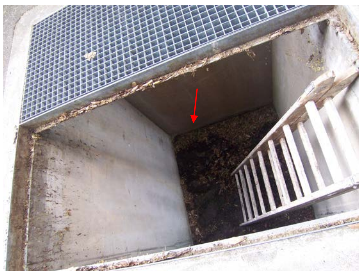
L'accumulation de feuilles a fini par boucher la grille pour l'écoulement de l'eau.
