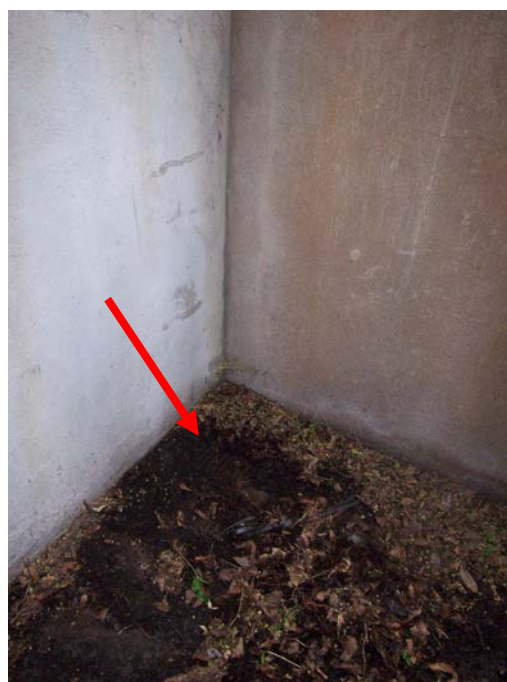
L'accumulation de feuilles a fini par boucher la grille pour l'écoulement de l'eau.
