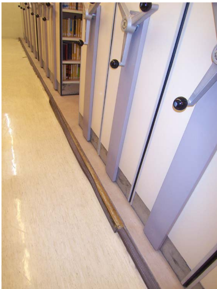
Le socle des étagères Compactus perd son bord : à réparer.
