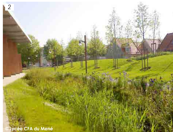
Noue drainante sur un sol très peu perméable. Les eaux stockées dans la noue s'infiltrent dans le substrat superficiel et sont drainées dans un massif qui évacue les eaux à débit régulé vers un exutoire. Source Architecture & Climat
