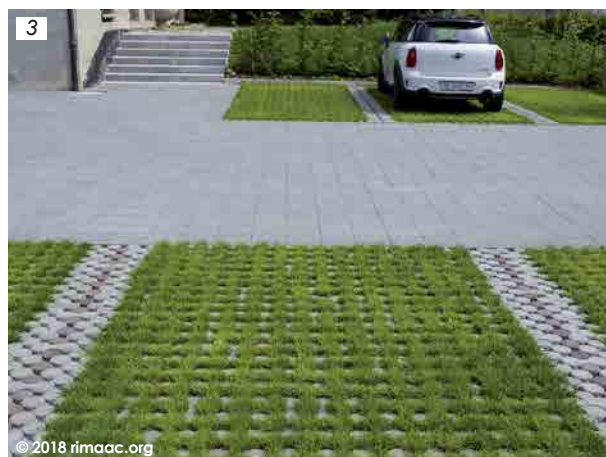
1-2-3 : Différents types de pavés engazonnés.
