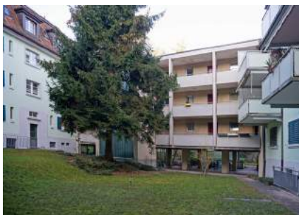
Gebäudeanschluss an die Kolonie 1 und der Hofraum mit der Laubengerschliessung
