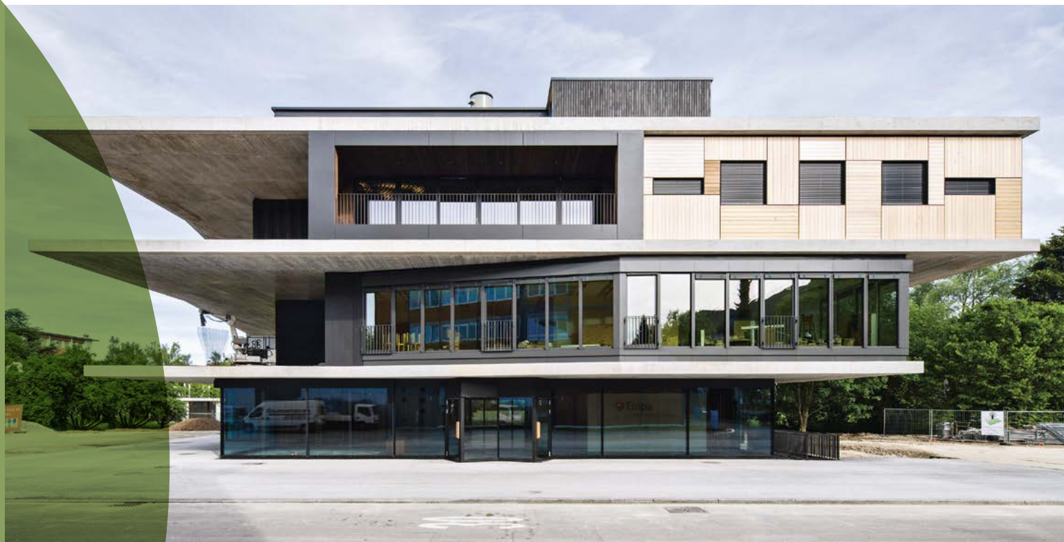
1_ Come un gigantesco magazzino a scaffalature: nella struttura portante fissa sono collocate le unità di ricerca intercambiabili. (Foto: Roman Keller)
