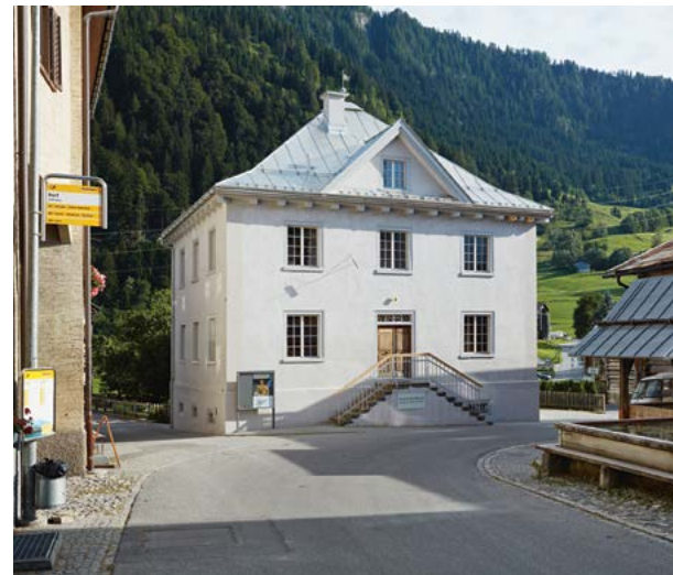
2_ La vecchia scuola, vista dalla piazza del paese, dopo la ristrutturazione.
