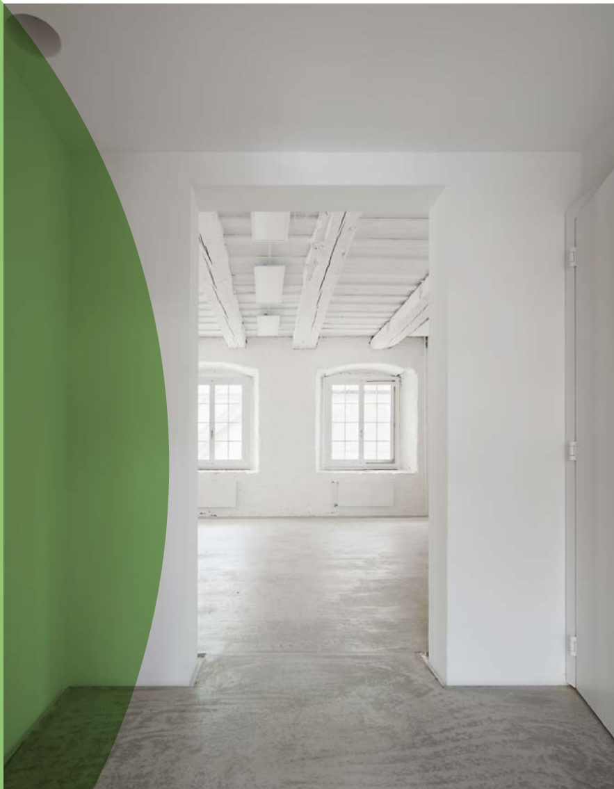
1_ Aperçu de l'ancienne salle de classe avec ses murs blanchis à la chaux. (Photos: Ralph Feiner)
