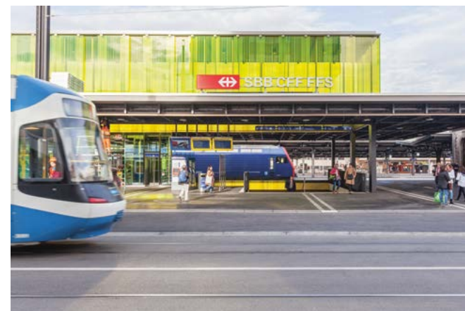
2_ Le costruzioni in vetro sono punti di riferimento ben visibili anche da lontano.
