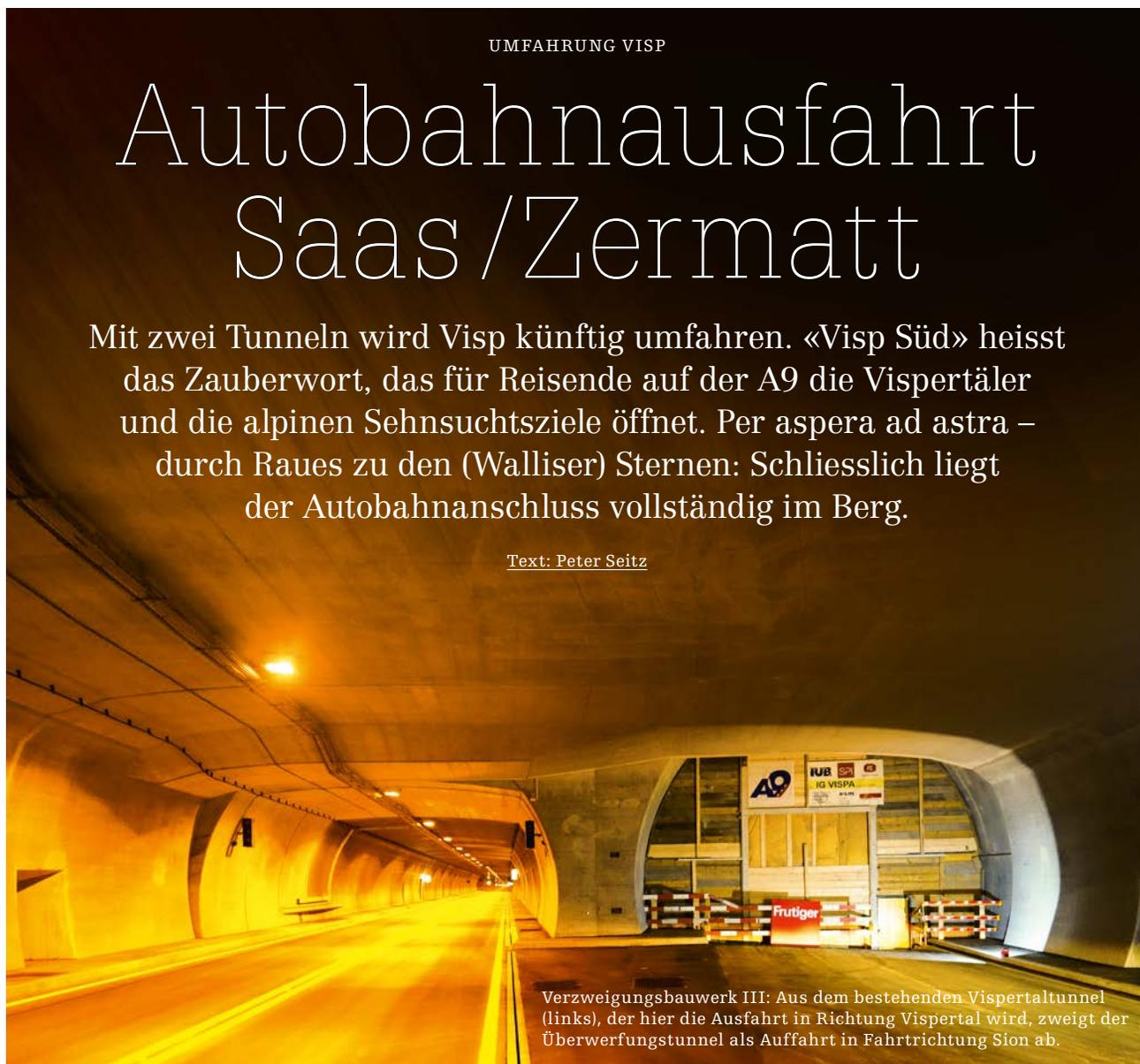
Verzweigungsbauwerk III: Aus dem bestehenden Vispertaltunnel (links), der hier die Ausfahrt in Richtung Vispertal wird, zweigt der Überwölbungstunnel als Auffahrt in Fahrtrichtung Sion ab.
