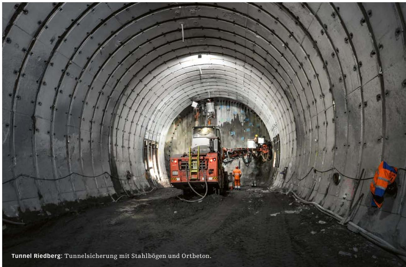
Tunnel Riedberg: Tunnelsicherung mit Stahlbögen und Ortbeton.
