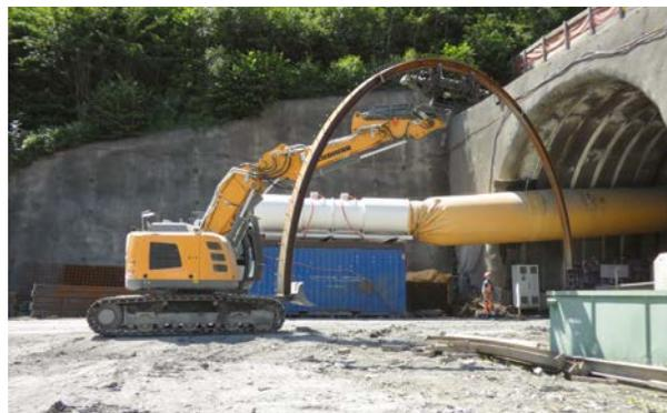
**Tunnel Riedberg:** Einfahren eines Stahlbogens zur Tunnelsicherung.
