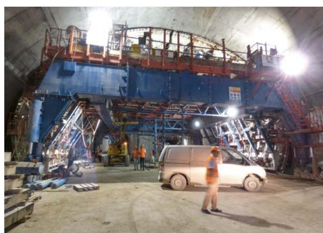
Einer von drei verfahrbaren Schalwagen im Tunnel Visp. Die Innenschale des Tunnels konnte dadurch in Ortbetonbauweise erstellt werden.
