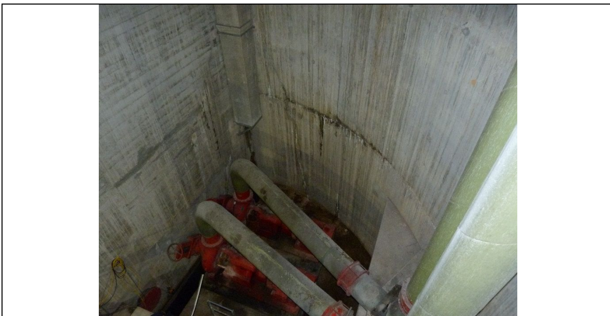
Photo 3 : Vue de l'intérieur de l'ouvrage en fond de fosse, quelques traces de suintements/calclites sont présentes au droit des reprises de bétonnage sur le mur externe ME1, pas de traces de corrosion.
