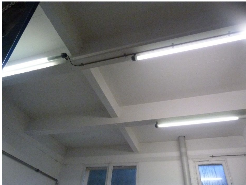
Photo 6 : pas de dégradations visible en sous face de la dalle toiture TT de cet ouvrage.
