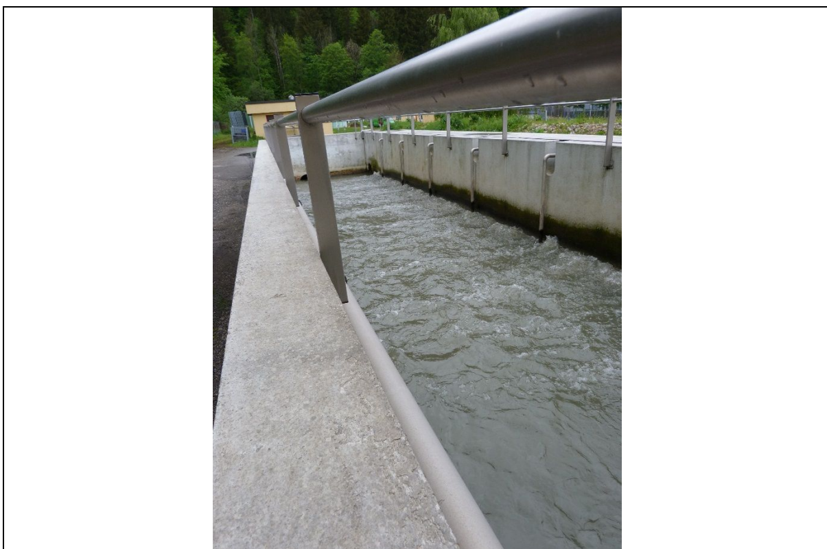
Photo 8 : canal de sortie du local de prétraitement, légère érosion des murs en contact avec l'eau.
