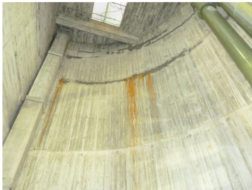
Photo 2 : Vue de l'intérieur de l'ouvrage, quelques traces de corrosion sont présentes au droit des reprises de bétonnage sur le mur externe ME1. DS en bon état général, pas de dégradation relevée.
