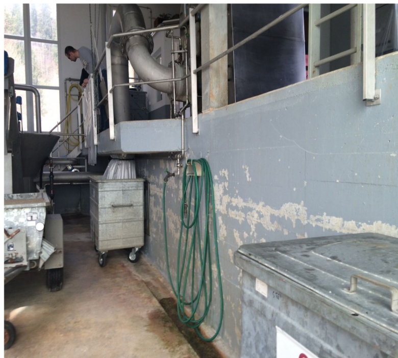
Photo 5 : mur contre les canaux de circulation des eaux CA1, pas de dégradations visibles.
