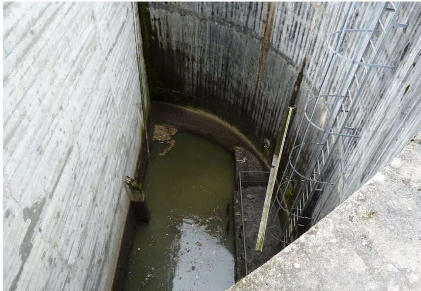
Photo 1 : Vue du fond de la fosse, quelques traces d'humidité/suintements sont présentes au droit de fissurations sur le mur externe ME1. Présence de traces de calcite sur ME1. Le mur intérieur de séparation MS est en bon état général.
