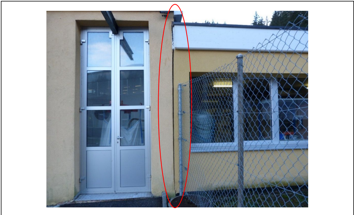
Photo 13 : Façade Nord-Est du bâtiment entre la zone "filtration" et la zone "atelier" (à droite) Cette photo nous montre la présence du joint de dilatation entre les deux locaux, il présente une ouverture plus prononcée en partie supérieure du bâtiment. Il ne s'agit donc pas d'une fissure puisque ce joint avait été prévu au moment de la construction du bâtiment.
