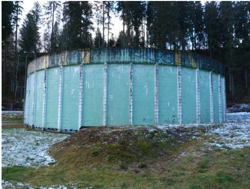
Photo 9 : dégradation visible en partie basse des murs maçonnerie, structure externe dégradée, cette partie d'ouvrage est en mauvais état général.
