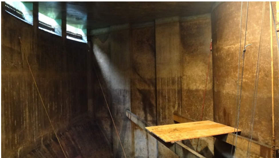
Photo 10 : intérieur du monobloc 2, lors de la vidange partielle de l'ouvrage en septembre 2013. Pas de dégradations significatives visibles sur la photo.
