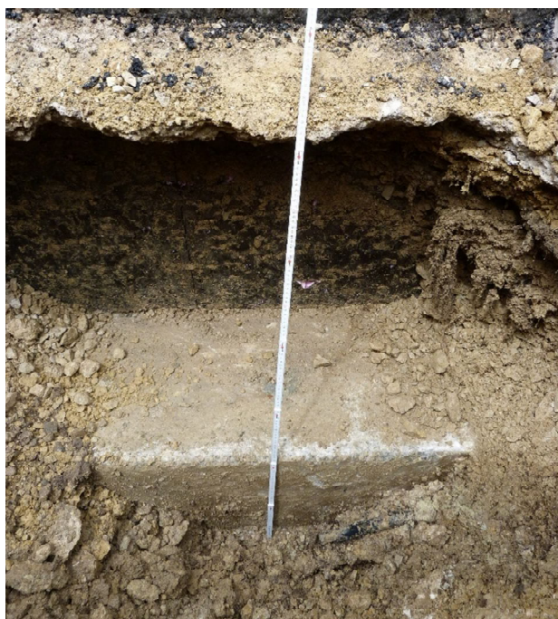
Photo 7 : reconnaissance de fondation contre le mur extérieur ME, épaisseur de radier de 40 cm et débord de 50 cm par rapport à l'isolant.
