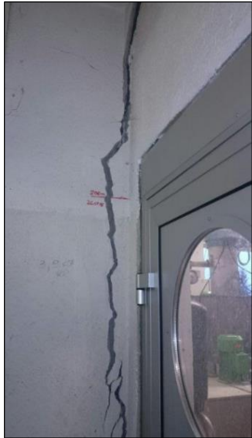
Bâtiment administratif / déshyd. des boues Déformations structurelles
