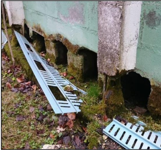
Monobloc Erosion du béton en surface
