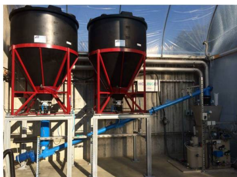
Système de dosage du CAP
