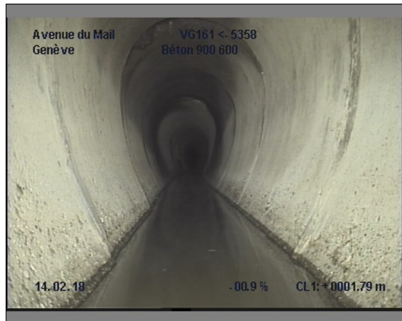
Photo: 15_15_133_A.JPG, 00:01:00 1.7m, Changement de direction à gauche, léger
