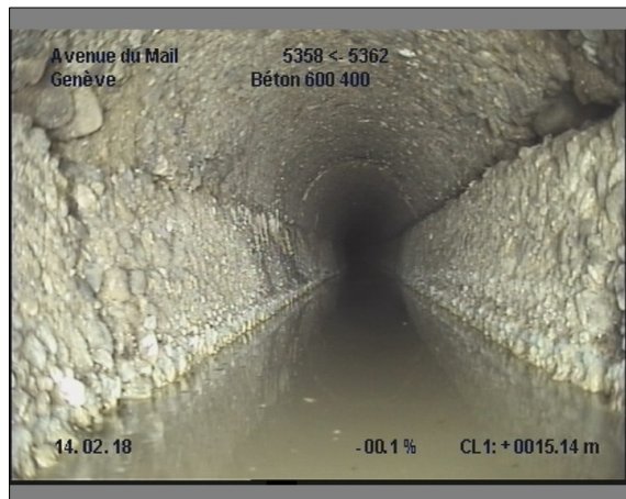
Photo: 17_17_162_A.JPG, 00:06:51 15.1m, Changement de direction à droite, léger
