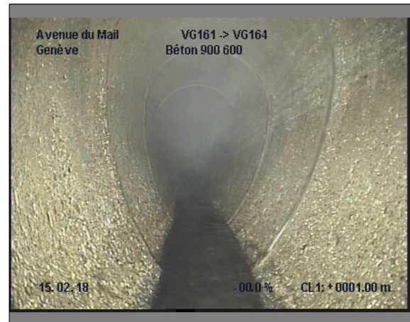
Photo: 14_14_258_A.JPG, 00:00:12 1m, Paroi du tuyau, importante dégradation du revêtement de 12 à 12 h.
