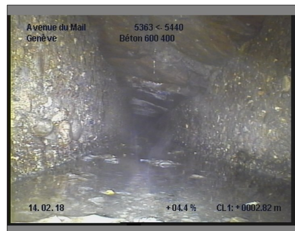
Photo: 26_26_247_A.JPG, 00:01:04 2.8m, Paroi du tuyau, importante dégradation du revêtement de 12 à 12 h.
