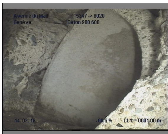
Photo: 10_10_70_B.JPG, 00:00:19 1m, Branchement à 02 h.
