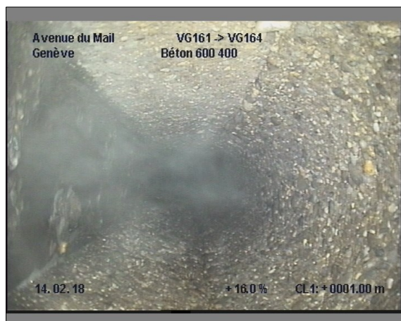
Photo: 12_12_105_A.JPG, 00:00:54 1m, Dépôt dur de 04 à 08 h.
