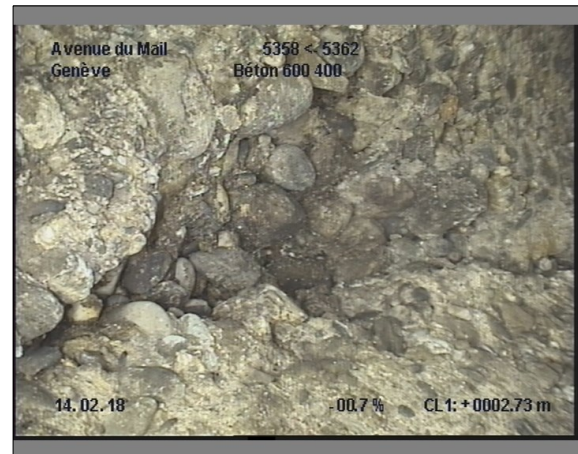
Photo: 17_17_154_B.JPG, 00:00:50 2.7m, Paroi du tuyau, importante dégradation du revêtement de 12 à 12 h.
