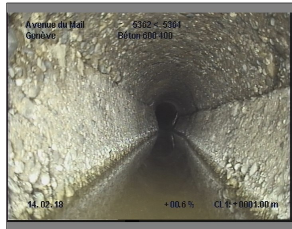
Photo: 21_21_190_A.JPG, 00:00:12 1m, Paroi du tuyau, importante dégradation du revêtement de 12 à 12 h.
