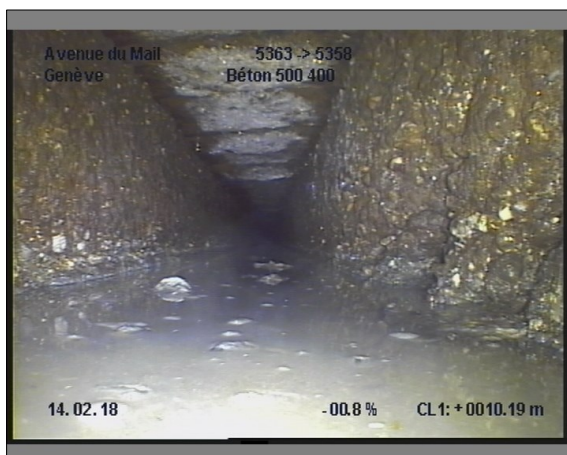
Photo: 25_25_232_A.JPG, 00:02:07 10.1m, Paroi du tuyau, importante dégradation du revêtement de 12 à 12 h.
