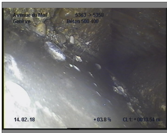
Photo: 25_25_238_B.JPG, 00:06:33 33.5m, Dépôt de gravier de 04 à 08 h.
