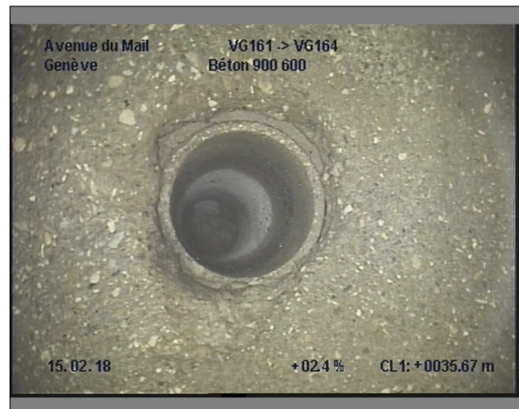
Photo: 14_14_267_B.JPG, 00:05:15 35.6m, Branchement à 11 h.
