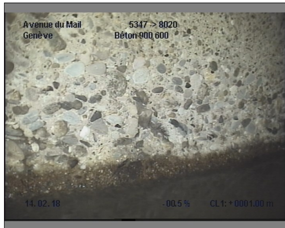
Photo: 10_10_71_B.JPG, 00:00:29 1m, Paroi du tuyau, moyenne dégradation du revêtement de 12 à 12 h.
