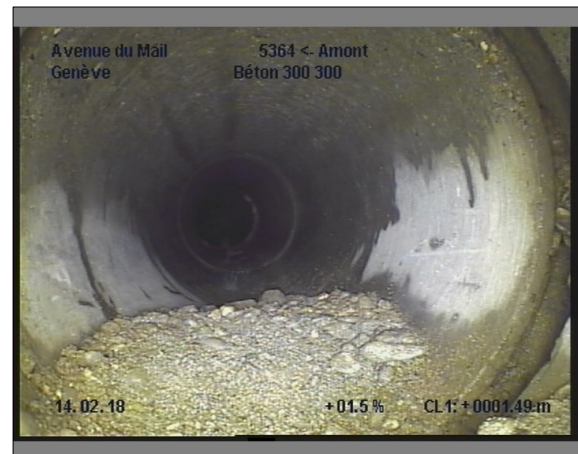
Photo: 24_24_221_A.JPG, 00:01:06 1.4m, Changement de direction à gauche, léger
