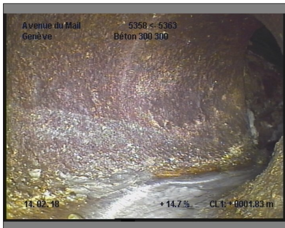
Photo: 18_18_172_A.JPG, 00:02:36 1.8m, Coude à droite
