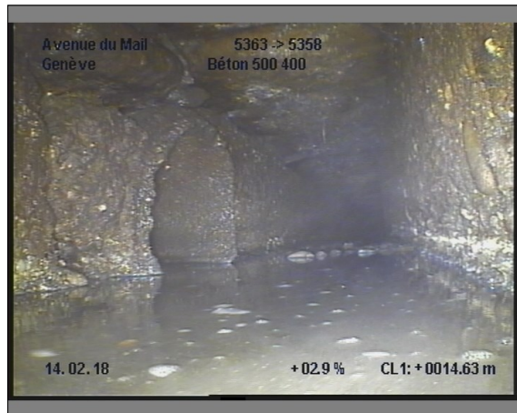
Photo: 25_25_233_A.JPG, 00:02:57 14.6m, Branchement à 09 h.
