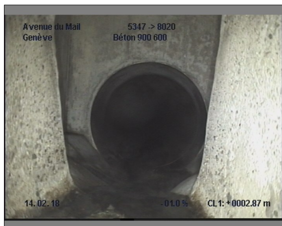
Photo: 10_10_75_A.JPG, 00:02:38 2.8m, Paroi du tuyau, moyenne dégradation du revêtement de 12 à 12 h.
