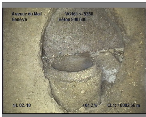
Photo: 15_15_134_B.JPG, 00:01:31 2.6m, Branchement à 11 h., pas crépi
