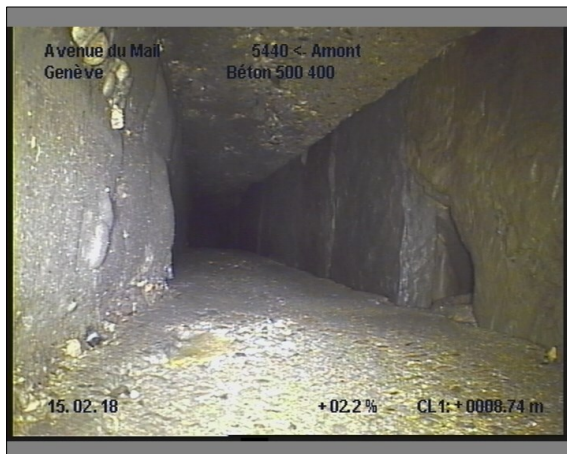
Photo: 29_29_285_A.JPG, 00:02:22 8.7m, Branchement à 01 h.
