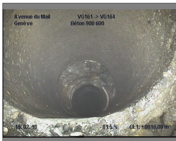
Photo: 14_14_262_B.JPG, 00:02:20 16m, Branchement à 10 h., pas crépi
