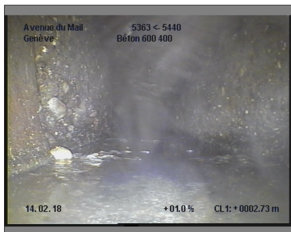
Photo: 26_26_246_A.JPG, 00:00:53 2.7m, Diminution du diamètre
