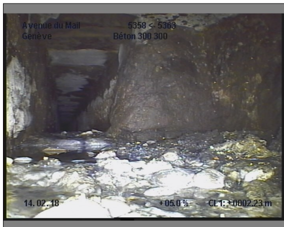
Photo: 18_18_175_A.JPG, 00:03:57 2.2m, Dépôt sur le radier
