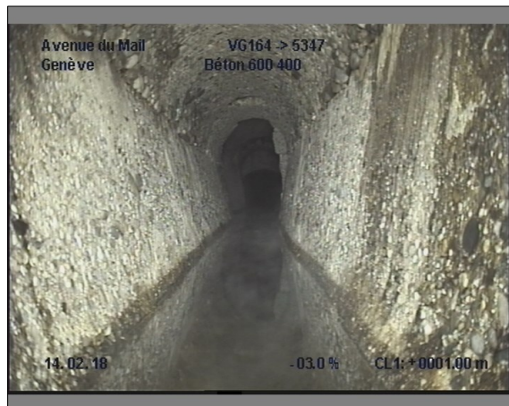
Photo: 9_9_62_A.JPG, 00:00:29 1m, Paroi du tuyau, importante dégradation du revêtement de 12 à 12 h.
