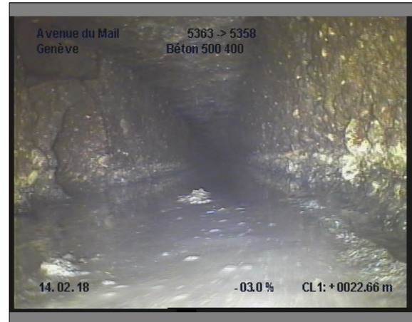
Photo: 25_25_236_A.JPG, 00:04:35 22.6m, Branchement à 09 h.
