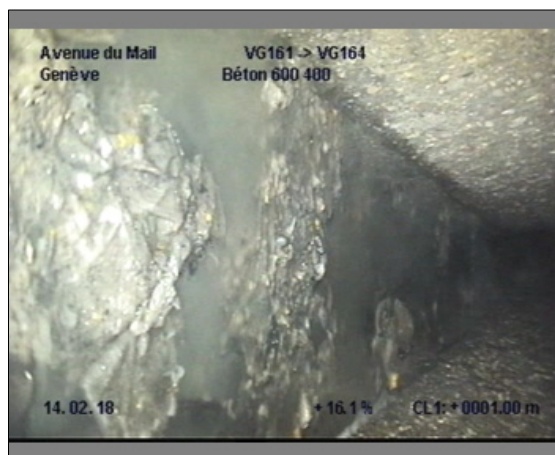
Photo: 12_12_108_B.jpg, 00:00:56 1m, Paroi du tuyau, importante dégradation du revêtement de 12 à 12 h.
