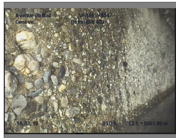
Photo: 9_9_62_B.JPG, 00:00:29 1m, Paroi du tuyau, importante dégradation du revêtement de 12 à 12 h.
