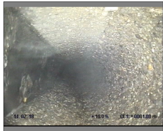
Photo: 12_12_108_A.jpg, 00:00:56 1m, Paroi du tuyau, importante dégradation du revêtement de 12 à 12 h.
