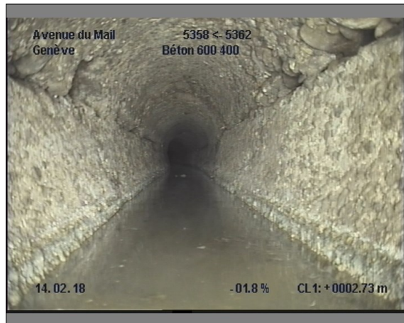
Photo: 17_17_154_A.JPG, 00:00:50 2.7m, Paroi du tuyau, importante dégradation du revêtement de 12 à 12 h.
