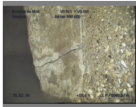
Photo: 14_14_271_B.JPG, 00:06:56 45.2m, Fissure(s) à 04 h.
