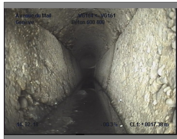
Photo: 11_11_94_A.JPG, 00:11:19 17.3m, Dépôt dur de 05 à 07 h.
