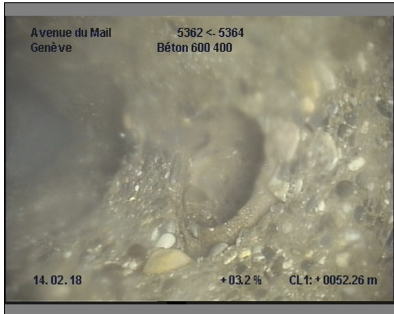
Photo: 21_21_203_B.JPG, 00:12:07 52.2m, Branchement à 01 h.
