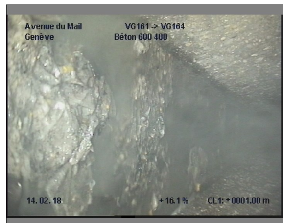
Photo: 12_12_105_B.JPG, 00:00:54 1m, Dépôt dur de 04 à 08 h.
