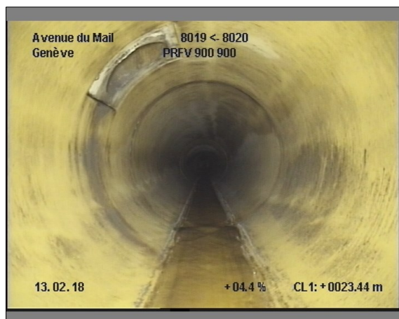
Photo: 6_6_33_A.JPG, 00:03:08 23.4m, Branchement à 11 h.
