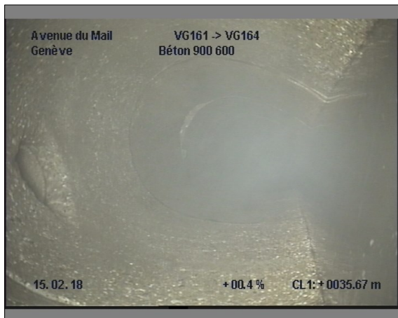
Photo: 14_14_267_A.JPG, 00:05:15 35.6m, Branchement à 11 h.
