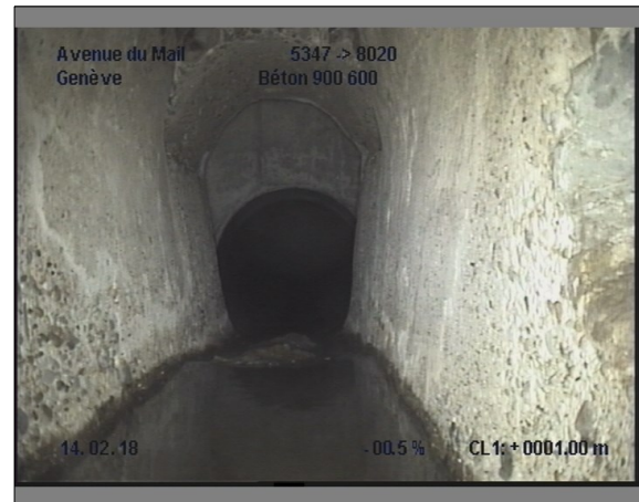
Photo: 10_10_72_A.JPG, 00:00:41 1m, Retenue d'eau
