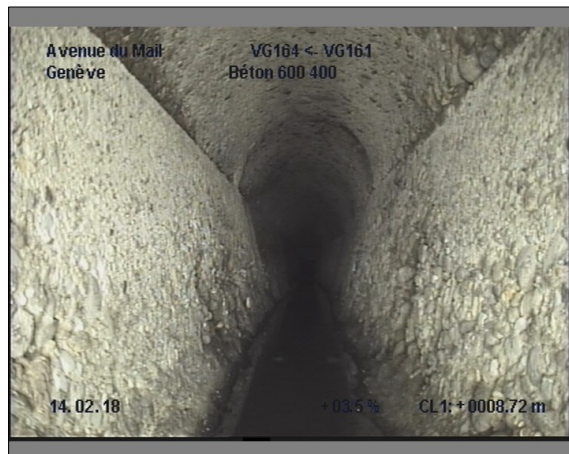
Photo: 11_11_89_A.JPG, 00:06:52 8.7m, Paroi du tuyau, importante dégradation du revêtement de 12 à 12 h.
