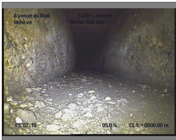
Photo: 29_29_282_A.JPG, 00:00:28 0.8m, Dépôt sur le radier, boue
