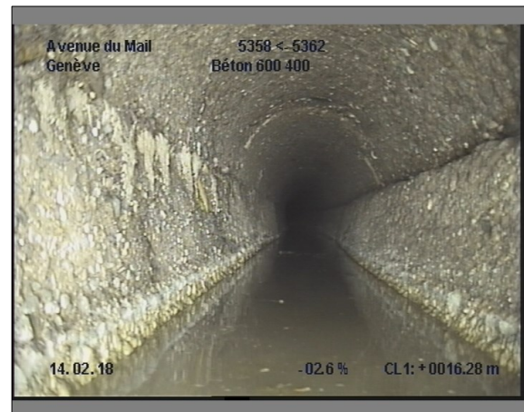
Photo: 17_17_163_A.JPG, 00:07:11 16.2m, Formation de calcaire de 09 à 10 h.
