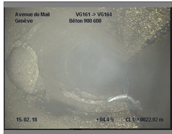
Photo: 14_14_264_A.JPG, 00:03:36 22.9m, Branchement à 11 h.
