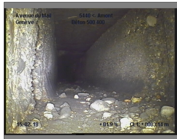
Photo: 29_29_283_A.JPG, 00:01:00 3.1m, Changement de direction à gauche, léger
