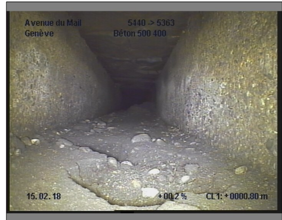
Photo: 28_28_276_A.JPG, 00:00:11 0.8m, Dépôt sur le radier, pierres
