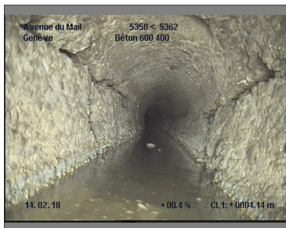
Photo: 17_17_155_A.JPG, 00:02:00 4.1m, Branchement à 12 h.
