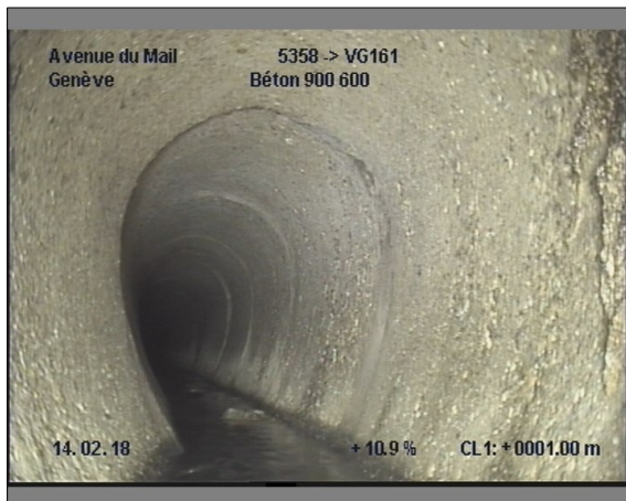
Photo: 16_16_148_A.JPG, 00:00:35 1m, Dépôt dur de 05 à 07 h.
