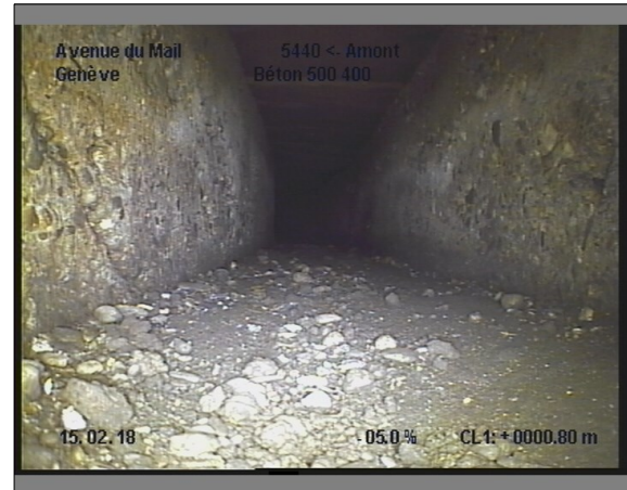
Photo: 29_29_281_A.JPG, 00:00:23 0.8m, Dépôt de gravier de 04 à 08 h.
