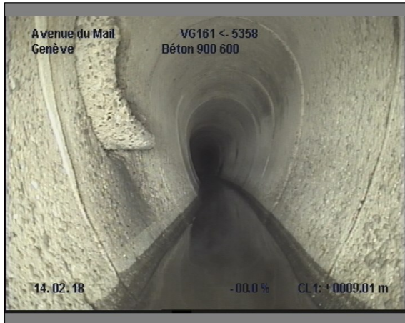
Photo: 15_15_138_A.JPG, 00:04:14 9m, Branchement à 09 h., moyennement pénétrant
