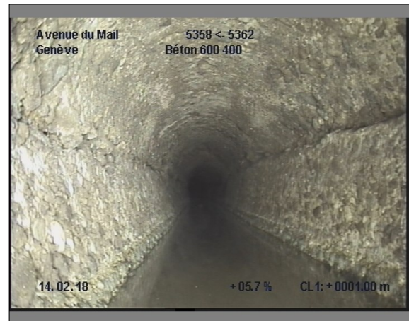
Photo: 17_17_152_A.JPG, 00:00:13 1m, Paroi du tuyau, importante dégradation du revêtement de 12 à 12 h.
