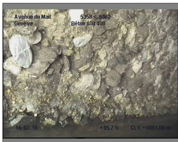
Photo: 17_17_152_B.JPG, 00:00:13 1m, Paroi du tuyau, importante dégradation du revêtement de 12 à 12 h.
