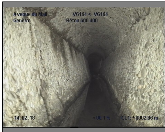
Photo: 11_11_82_A.JPG, 00:01:51 2.8m, Changement de direction à droite, léger
