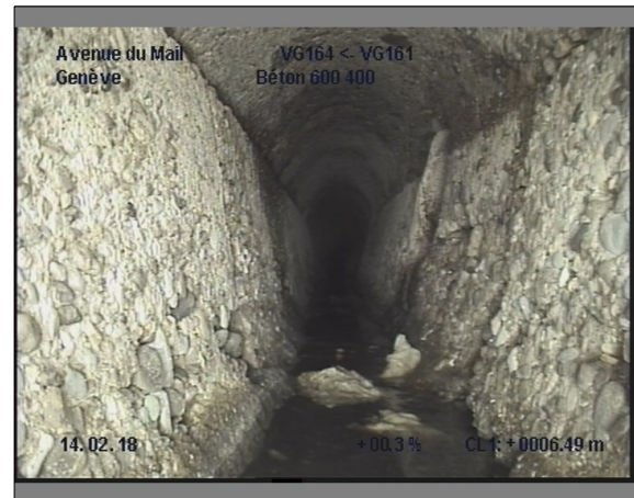
Photo: 11_11_86_A.JPG, 00:04:51 6.4m, Paroi du tuyau, importante dégradation du revêtement de 12 à 12 h.
