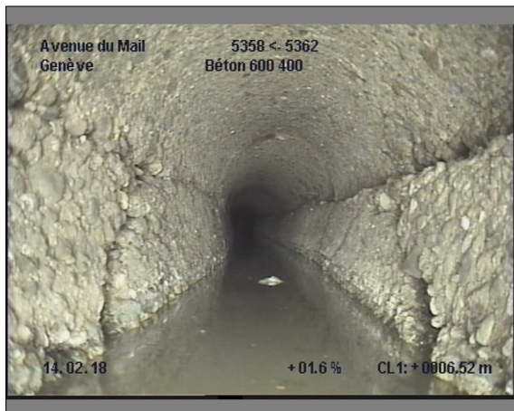
Photo: 17_17_158_A.JPG, 00:03:54 6.5m, Paroi du tuyau, importante dégradation du revêtement de 12 à 12 h.
