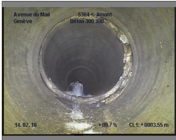
Photo: 24_24_222_A.JPG, 00:01:23 3.5m, Assemblage défectueux, moyennement décalée de 12 à 12 h.
