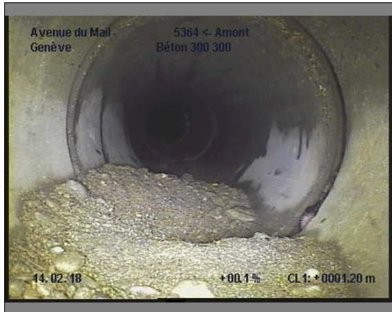
Photo: 24_24_219_A.JPG, 00:00:22 1.2m, Dépôt sur le radier, sable
