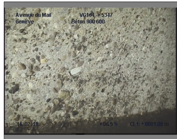
Photo: 8_8_51_B.JPG, 00:02:01 1m, Paroi du tuyau, légère dégradation du revêtement de 12 à 12 h.
