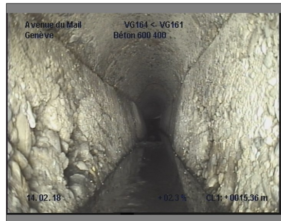
Photo: 11_11_92_A.JPG, 00:09:21 15.3m, Paroi du tuyau, importante dégradation du revêtement de 12 à 12 h.
