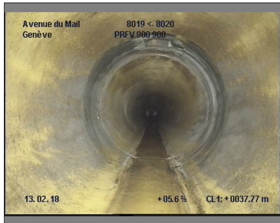
Photo: 6_6_34_A.JPG, 00:04:05 37.7m, Branchement à 12 h.
