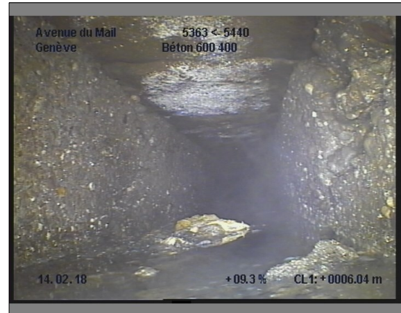
Photo: 26_26_250_A.JPG, 00:02:09 6m, Fissure(s) de 07 à 11 h.
