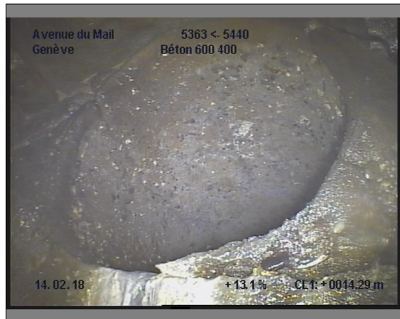
Photo: 26_26_251_B.JPG, 00:03:21 14.2m, Branchement à 02 h.
