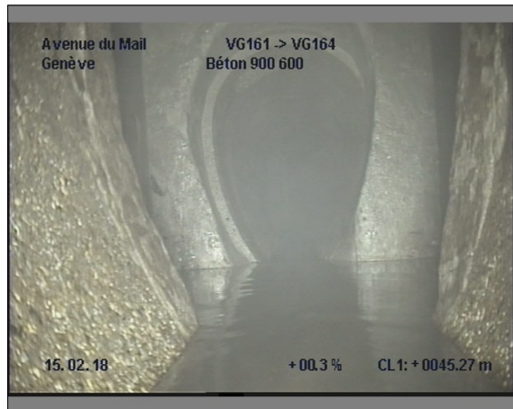
Photo: 14_14_271_A.JPG, 00:06:56 45.2m, Fissure(s) à 04 h.
