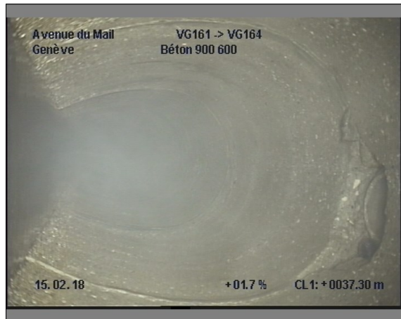
Photo: 14_14_268_A.JPG, 00:05:42 37.3m, Branchement à 01 h., pas crépi
