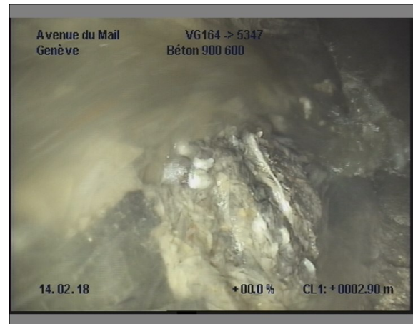
Photo: 8_8_54_B.JPG, 00:03:26 2.9m, Dépôt sur le radier
