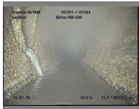
Photo: 14_14_265_A.JPG, 00:03:59 23.7m, Branchement à 09 h., pas crépi
