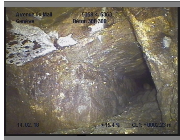
Photo: 18_18_174_B.JPG, 00:03:29 2.2m, Branchement à 03 h.
