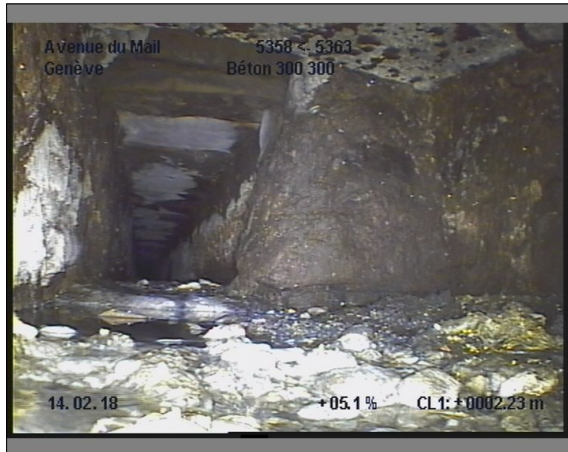
Photo: 18_18_176_A.JPG, 00:04:17 2.2m, Paroi du tuyau, importante dégradation du revêtement de 12 à 12 h.
