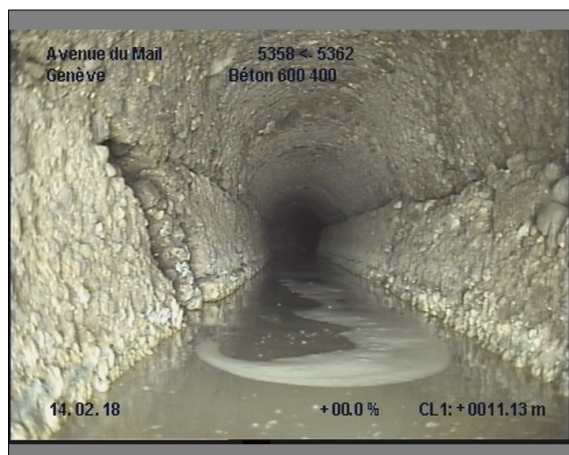
Photo: 17_17_160_A.JPG, 00:05:24 11.1m, Fissure(s) de 07 à 10 h.
