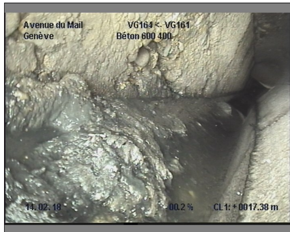
Photo: 11_11_94_B.JPG, 00:11:19 17.3m, Dépôt dur de 05 à 07 h.
