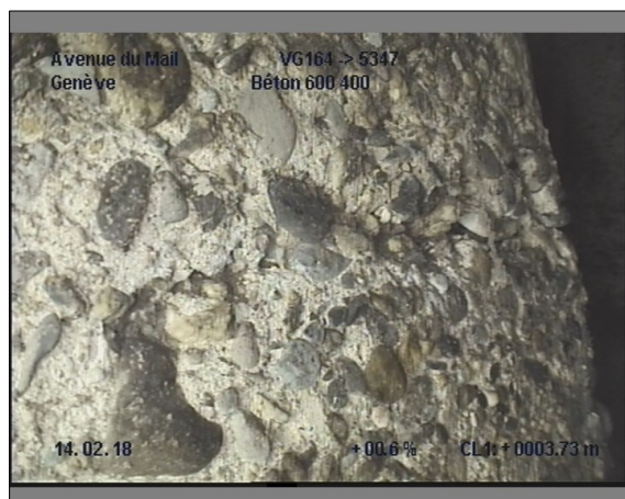
Photo: 9_9_66_B.JPG, 00:02:21 3.7m, Fissure(s) à 09 h.
