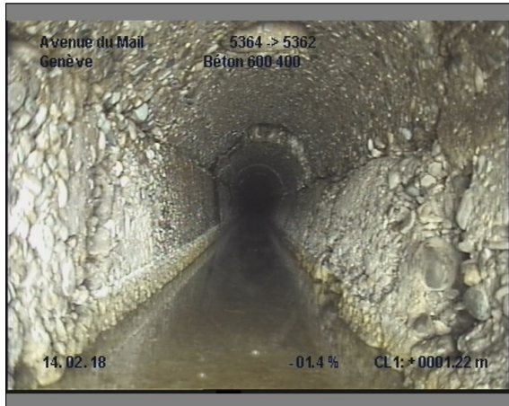
Photo: 23_23_211_A.JPG, 00:01:08 1.2m, Branchement à 12 h., pas crépi
