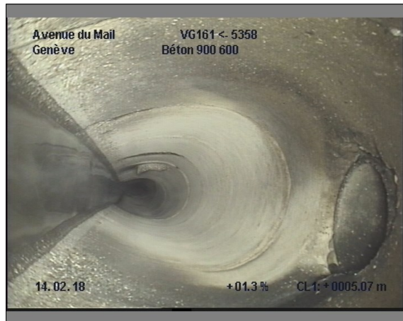
Photo: 15_15_136_A.JPG, 00:02:49 5m, Branchement à 12 h.
