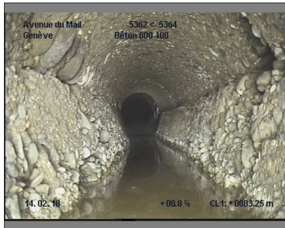
Photo: 21_21_192_A.JPG, 00:00:52 3.2m, Paroi du tuyau, importante dégradation du revêtement de 12 à 12 h.
