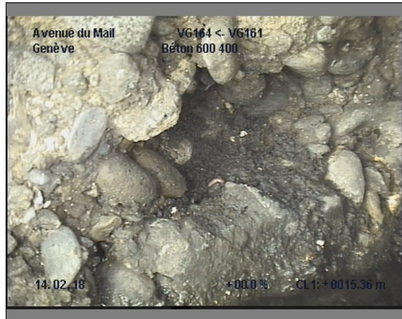
Photo: 11_11_92_B.JPG, 00:09:21 15.3m, Paroi du tuyau, importante dégradation du revêtement de 12 à 12 h.
