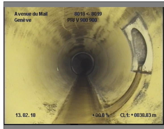
Photo: 5_5_24_A.JPG, 00:04:49 38.8m, Branchement à 02 h.
