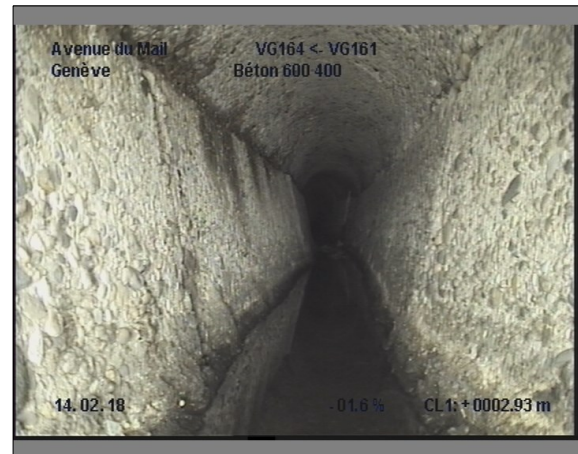
Photo: 11_11_83_A.JPG, 00:02:22 2.9m, Fissure(s) de 12 à 12 h.
