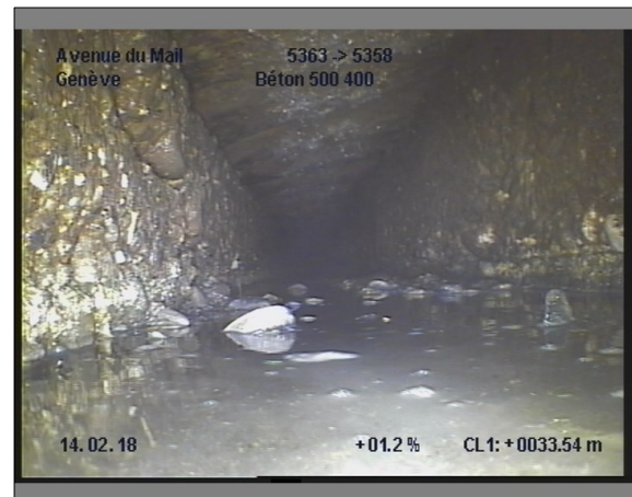
Photo: 25_25_237_A.JPG, 00:06:22 33.5m, Fissure(s) de 06 à 10 h.
