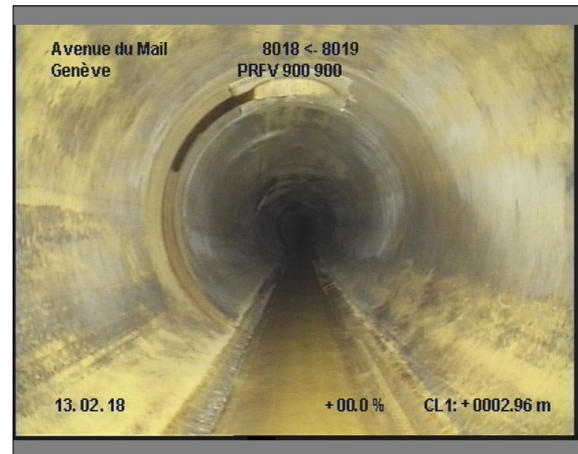
Photo: 5_5_17_A.JPG, 00:00:47 2.9m, Branchement à 12 h.
