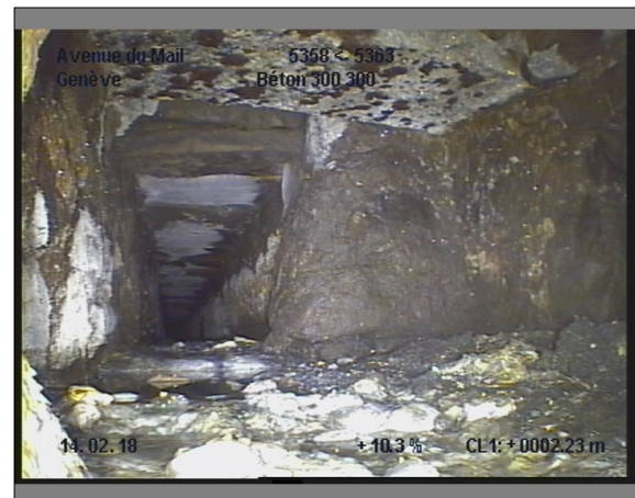
Photo: 18_18_173_A.JPG, 00:03:01 2.2m, Augmentation du diamètre
