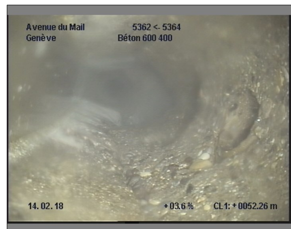
Photo: 21_21_203_A.JPG, 00:12:07 52.2m, Branchement à 01 h.
