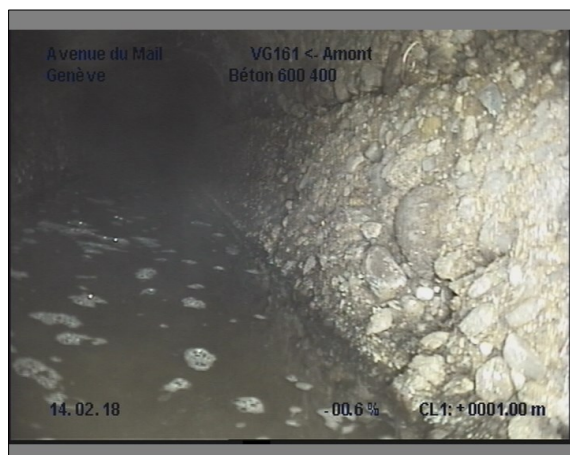
Photo: 13_13_111_B.JPG, 00:00:27 1m, Paroi du tuyau, importante dégradation du revêtement de 12 à 12 h.
