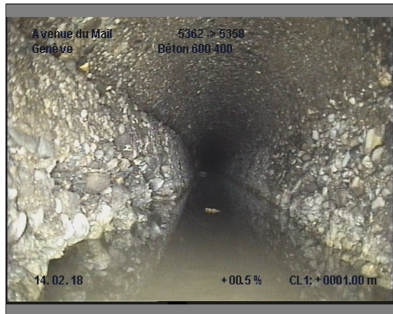
Photo: 19_19_185_A.JPG, 00:00:17 1m, Paroi du tuyau, importante dégradation du revêtement de 12 à 12 h.
