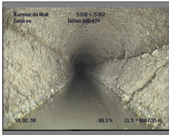
Photo: 17_17_159_A.JPG, 00:04:28 7.3m, Fissure(s) de 02 à 05 h.
