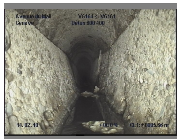
Photo: 11_11_84_A.JPG, 00:03:56 5.6m, Paroi du tuyau, importante dégradation du revêtement de 12 à 12 h.
