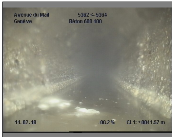
Photo: 21_21_201_A.JPG, 00:09:33 41.5m, Changement de direction à droite, léger
