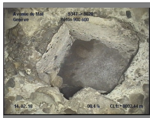
Photo: 10_10_73_B.JPG, 00:01:14 2.4m, Branchement à 12 h., pas crépi
