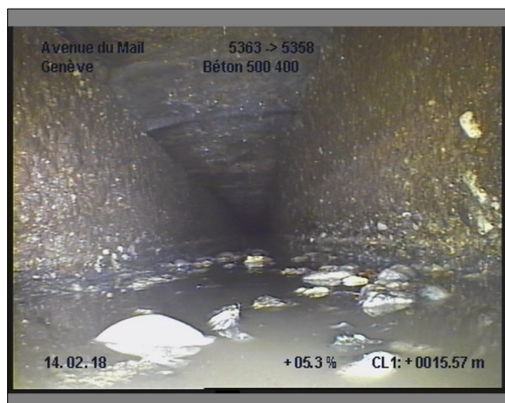
Photo: 25_25_234_A.JPG, 00:03:25 15.5m, Dépôt de gravier de 04 à 08 h.
