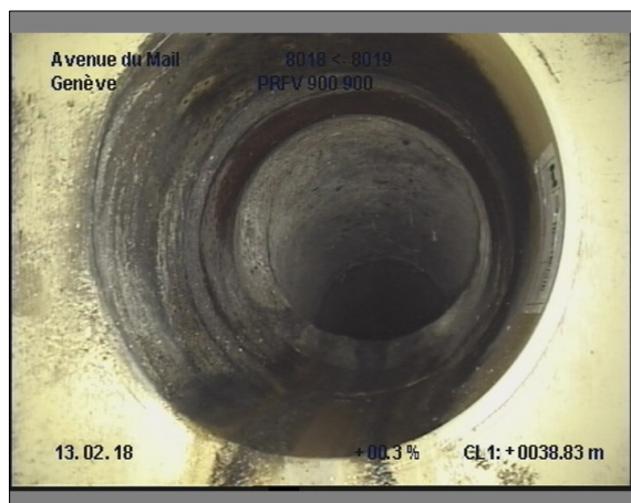
Photo: 5_5_24_B.JPG, 00:04:49 38.8m, Branchement à 02 h.
