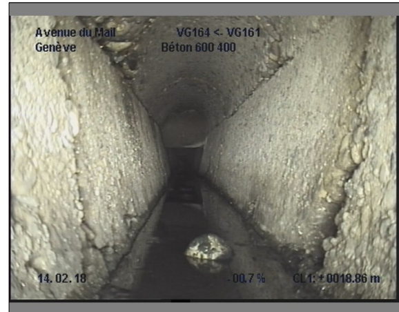
Photo: 11_11_98_A.JPG, 00:16:08 18.8m, Dépôt dur de 05 à 07 h.
