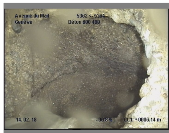
Photo: 21_21_193_B.JPG, 00:01:40 6.1m, Branchement à 01 h., légèrement pénétrant
