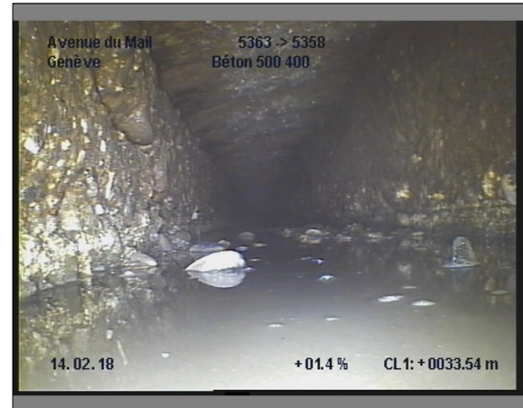
Photo: 25_25_238_A.JPG, 00:06:33 33.5m, Dépôt de gravier de 04 à 08 h.
