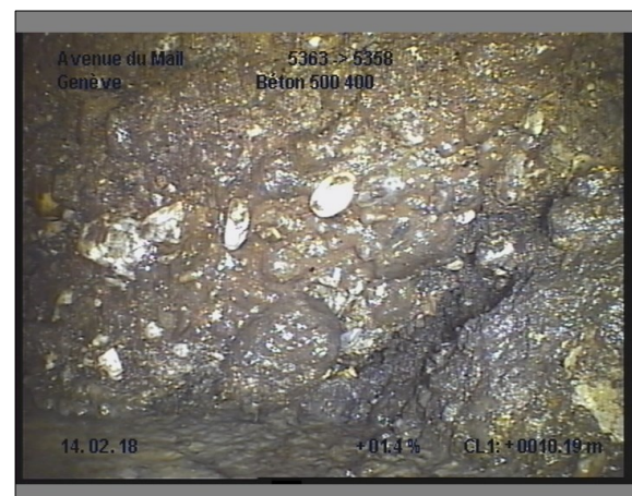
Photo: 25_25_232_B.JPG, 00:02:07 10.1m, Paroi du tuyau, importante dégradation du revêtement de 12 à 12 h.
