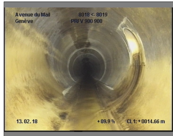
Photo: 5_5_19_A.JPG, 00:02:04 14.6m, Branchement à 03 h.
