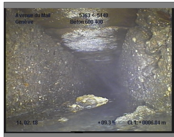
Photo: 26_26_249_A.JPG, 00:01:56 6m, Dépôt de gravier de 04 à 08 h.
