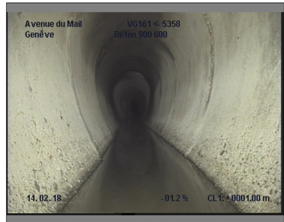
Photo: 15_15_131_A.JPG, 00:00:27 1m, Paroi du tuyau, légère dégradation du revêtement de 12 à 12 h.
