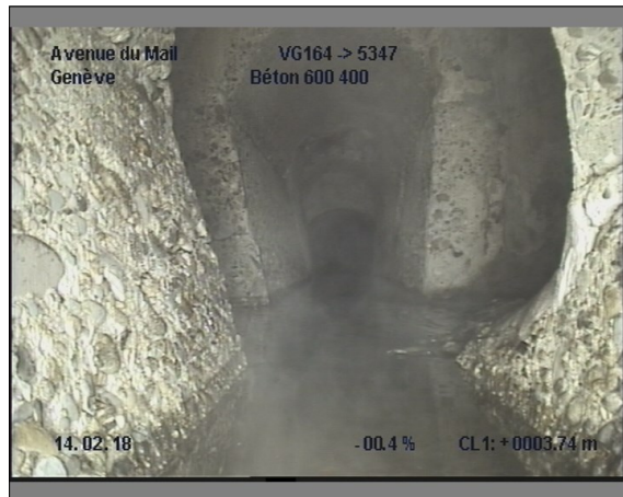
Photo: 9_9_65_A.JPG, 00:02:01 3.7m, Paroi du tuyau, importante dégradation du revêtement de 12 à 12 h.
