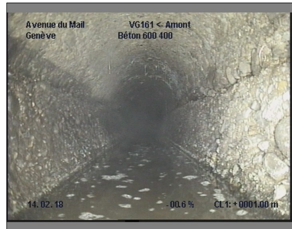
Photo: 13_13_111_A.JPG, 00:00:27 1m, Paroi du tuyau, importante dégradation du revêtement de 12 à 12 h.
