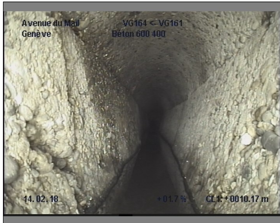
Photo: 11_11_90_A.JPG, 00:07:31 10.1m, Contre-pente ou flache
