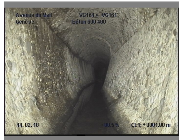
Photo: 11_11_80_A.JPG, 00:00:32 1m, Paroi du tuyau, importante dégradation du revêtement de 12 à 12 h.
