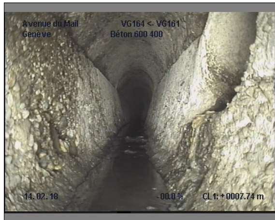
Photo: 11_11_88_A.JPG, 00:06:00 7.7m, Branchement à 03 h.
