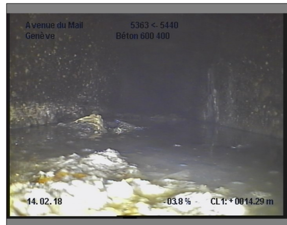
Photo: 26_26_251_A.JPG, 00:03:21 14.2m, Branchement à 02 h.
