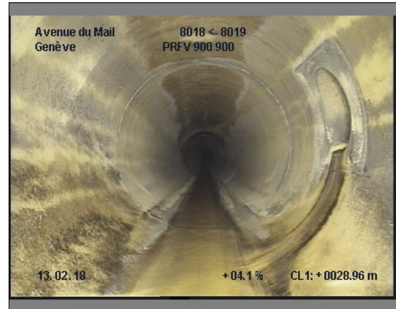
Photo: 5_5_21_A.JPG, 00:03:25 28.9m, Branchement à 03 h.
