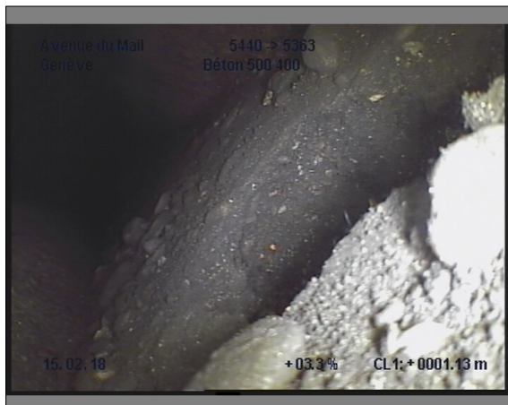
Photo: 28_28_277_A.JPG, 00:01:10 1.1m, Dépôt sur le radier, boue
