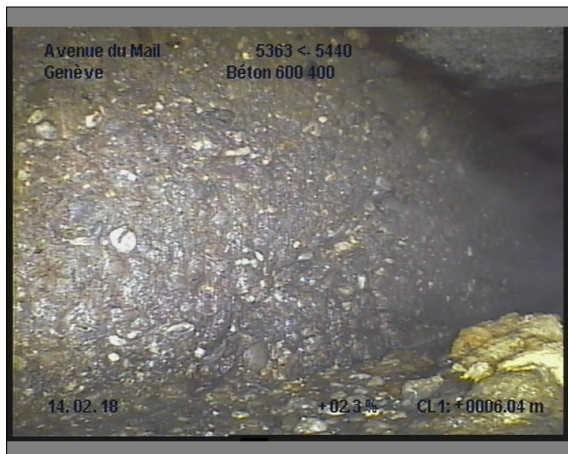
Photo: 26_26_250_B.JPG, 00:02:09 6m, Fissure(s) de 07 à 11 h.
