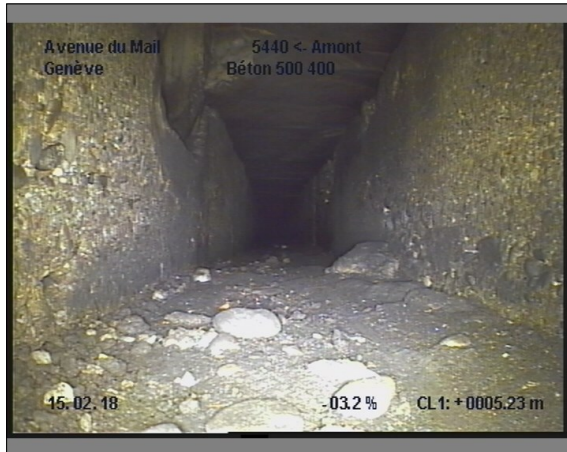
Photo: 29_29_284_A.JPG, 00:01:18 5.2m, Branchement à 10 h., pas crépi
