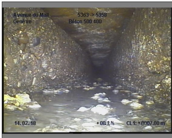
Photo: 25_25_231_A.JPG, 00:01:21 7m, Fissure(s) de 07 à 10 h.
