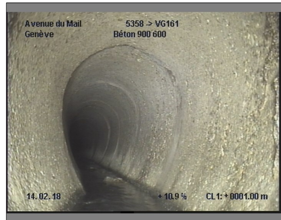
Photo: 16_16_147_A.JPG, 00:00:12 1m, Paroi du tuyau, importante dégradation du revêtement de 05 à 07 h.
