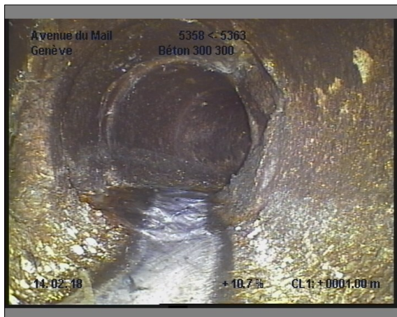
Photo: 18_18_169_A.JPG, 00:00:43 1m, Paroi du tuyau, légère dégradation du revêtement de 12 à 12 h.
