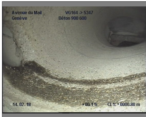
Photo: 8_8_49_A.JPG, 00:00:49 0.8m, Branchement à 11 h.
