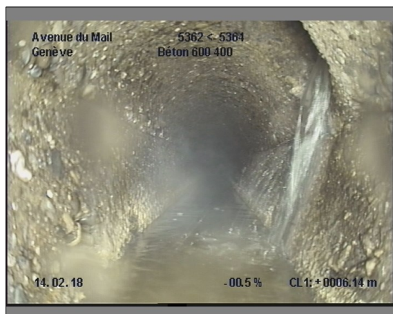
Photo: 21_21_193_A.JPG, 00:01:40 6.1m, Branchement à 01 h., légèrement pénétrant
