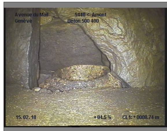
Photo: 29_29_285_B.JPG, 00:02:22 8.7m, Branchement à 01 h.
