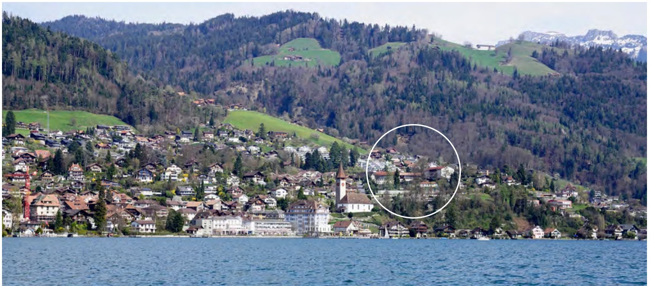
Abb. 3 Sicht vom Thunersee - aus diesem Blickwinkel ist die ganze Schulanlage knapp erkennbar
