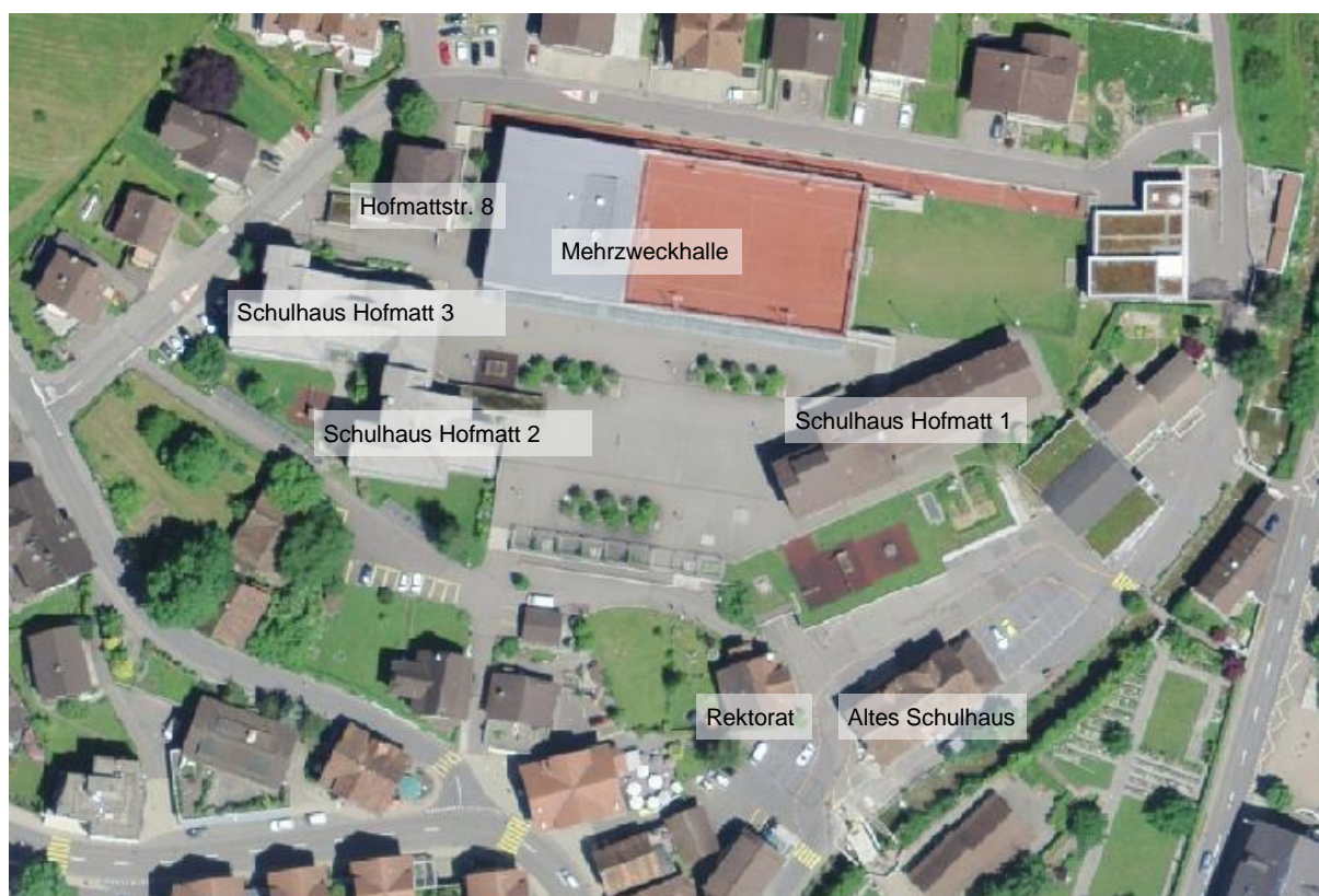
Abbildung 1: Luftbild Schulareal Hofmatt mit Schulgebäuden; Hofmatt 1 noch ohne Anbau (Quelle: GIS Kanton Zug, www.zugmap.ch )
