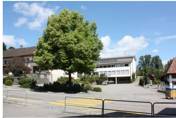
Südansicht Mehrzweckhalle mit integrierter Feuerwehr und Kindergarten
