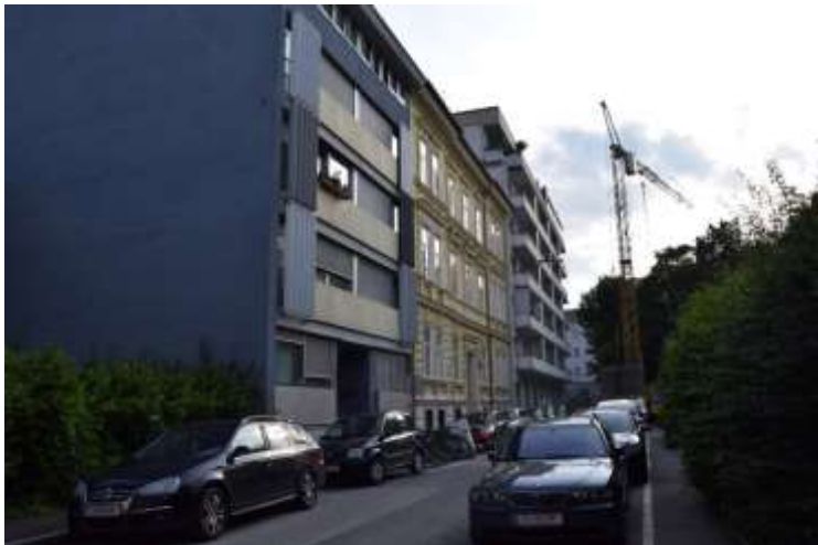
Hauslabgasse - Blick Richtung Osten zur Nachbarbebauung, eigene Aufnahme vom 06.06.2018
