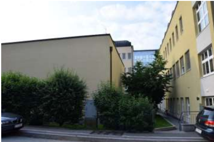
Hauslabgasse - Bereich zwischen den Bibliotheksgebäuden und den Institutsgebäuden (Bereich E), eigene Aufnahme vom 06.06.2018
