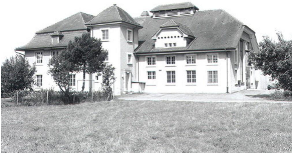
Energiezentrale (Umformerstation) von 1916, Gemeinde Bätterkinden
