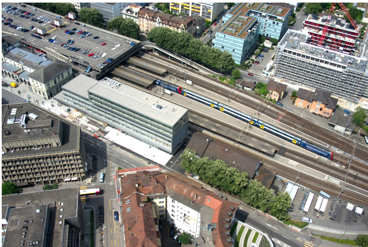
Realisiertes Stellwerk 1 mit nordöstlich angrenzendem Betriebsgebäude «Milchküche» (mittlerweile abgebrochen)
