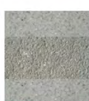
Béton sablé / bouchardé
