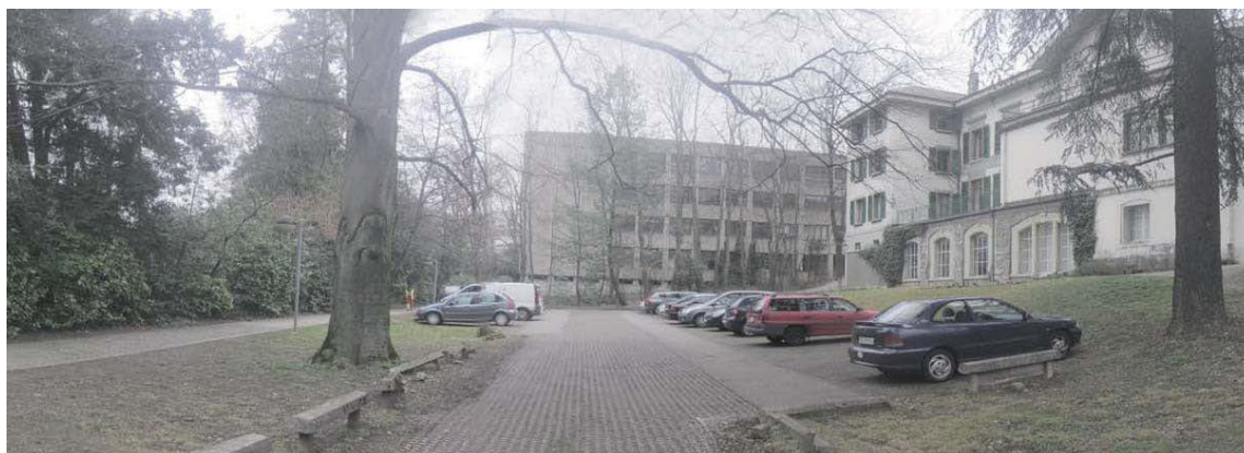
Façade ouest de la villa Thury 6 à droite et façade sud de la HEdS au fond
