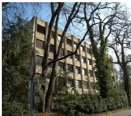
Façade HEdS sur chemin Thury
