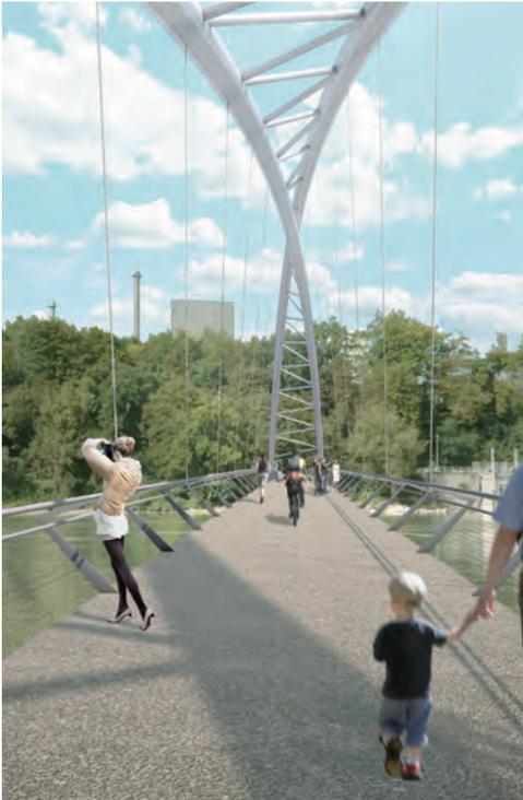
Das Brückentragwerk in Stahlbauweise besteht aus sich kreuzenden, aber konstruktiv miteinander verbundenen Bögen, von denen der Überbau abgehängt ist. Das Konzept des sich zeichenhaft kreuzenden Bogenpaars ist der Kern des Entwurfskonzeptes. Der formalistische Ansatz wirkt jedoch technisch unnötig kompliziert, ohne dass ein gestalterischer, funktionaler oder konstruktiver Mehrwert erkennbar wird. Die Konstruktion wirkt insgesamt beliebig.
