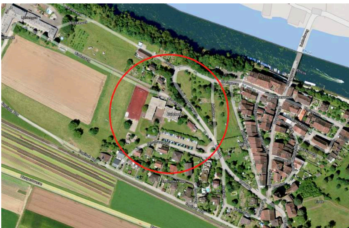
Flugaufnahme des Areals Blöleboden westlich der historischen Altstadt von Kaiserstuhl AG
